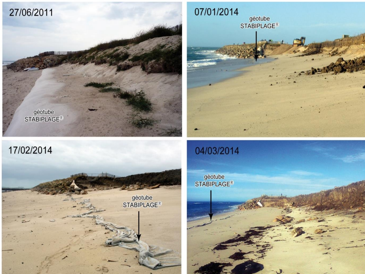
Figure 147 - Erosion du trait de côte et destruction des ouvrages de défense de la plage de Léhan à Treffiagat – sud Finistère.
