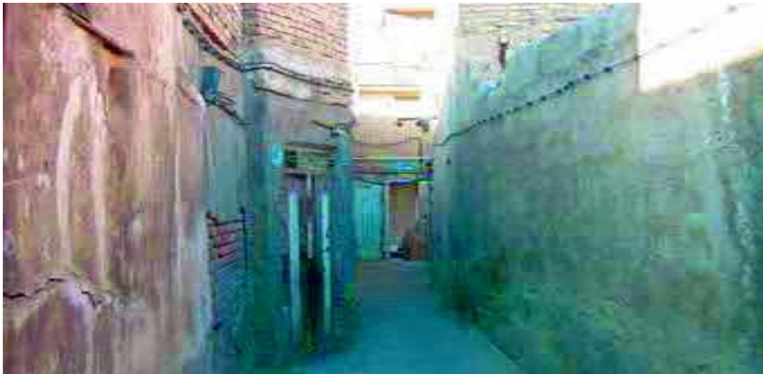
Photo 24-25 : Immobilier ancien et historique Source; Atlas de Téhéran
