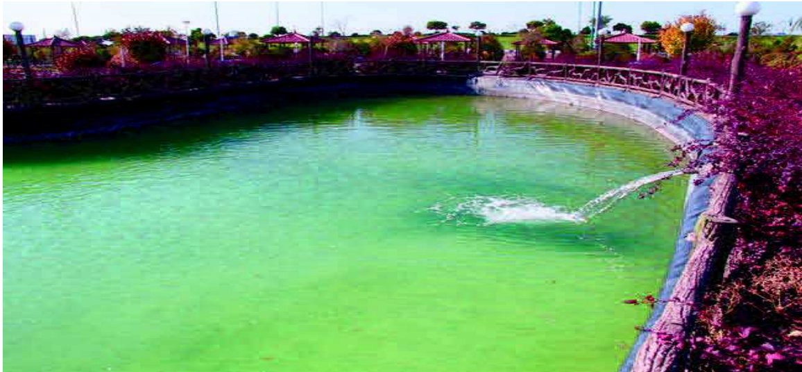
Photo 7 : Alimentation et stockage d'eau: http://d-alielmi.blogfa.com/post/32
