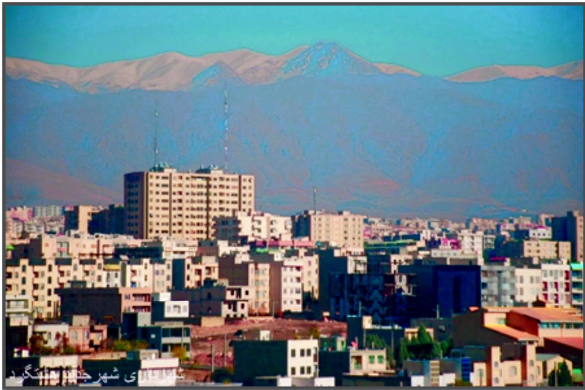
Photo 36: La construction et la densité urbaine dans la nouvelle ville de Hashtgerd ;Source : hashtgerdnc.ir
