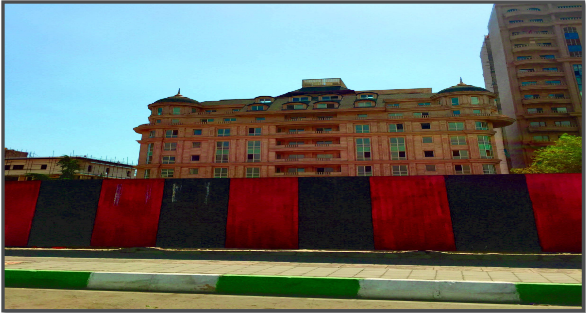
Photo 26: Matériaux de construction; Photo: AZARI 2014
