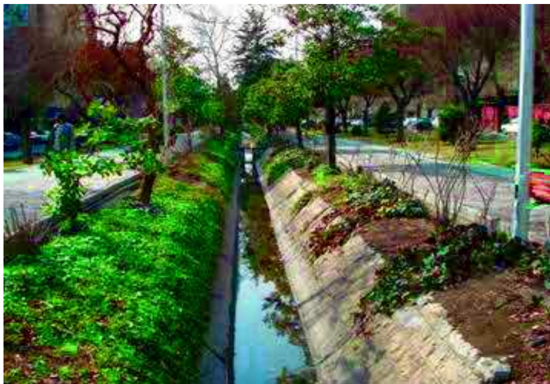
Photo 18 : Drainage urbain des eaux de pluie ; Source: atlas de Téhéran- Ramassage de l'eau de pluie
