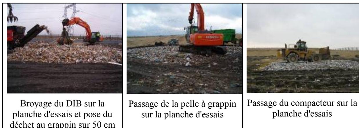
Figure 24 : Essai préliminaire de l'impact de la compaction sur la densité pour différents types de déchets
