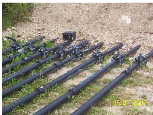
Drains d'alimentation du dispositif N°2 (8 chambres)
