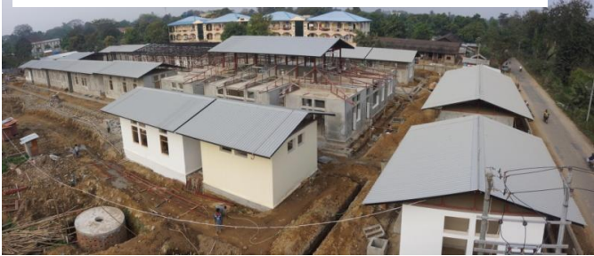
Figure 62 – Construction CICR, centre de réadaptation physique, Myitkyina, Région du Kachin, Myanmar, 2015
