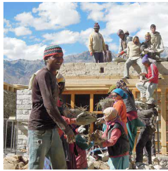
Construction d'une école au Zanskar, Inde
