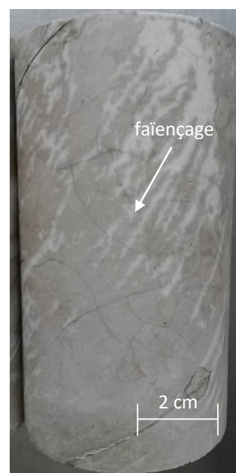
Figure VI-9 État d'une éprouvette K25C200 après un chauffage à 450 °C.
