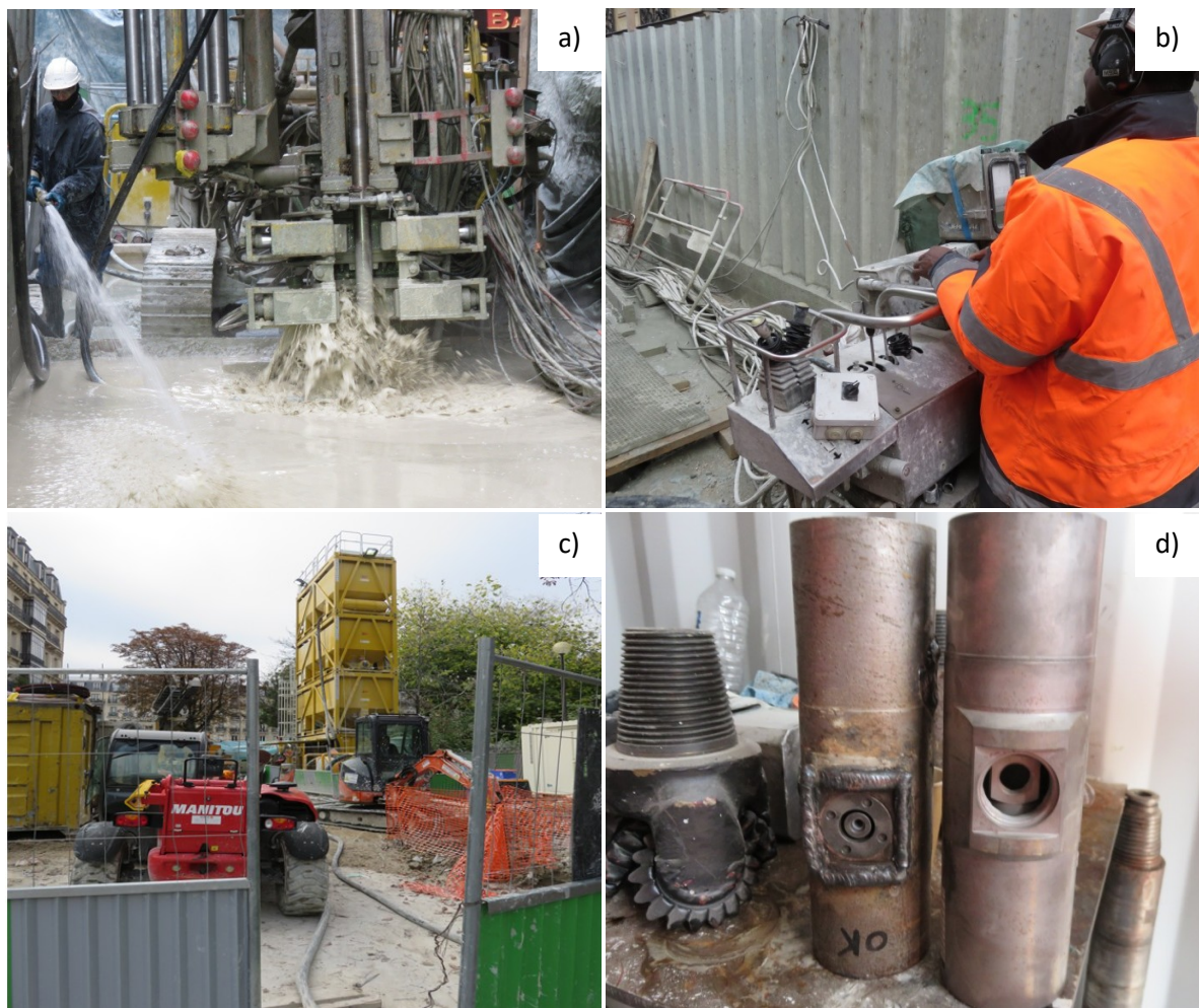
Figure I-9 Chantier de jet-grouting à mairie de Saint-Ouen: a) foreuse, b) poste de pilotage, c) centrale de fabrication du coulis, et d) tête de l'outil (système jet double).
