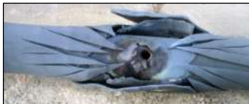
Figure 4 : Impact du claquage d'un câble : Le câble est détruit par un court-circuit interne
