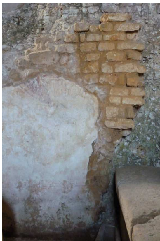
Figure 209 : Mur oriental, photographie dans le visible
