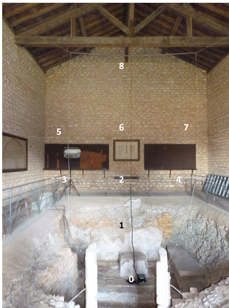
Figure 210 : Panneau central. Les câbles ne touchent aucune maçonnerie historique. Ce panneau est composé de 9 thermo hygromètres (M 0 à M 8 ).
