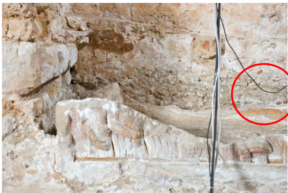
Figure 204 : Bas de l'arcosolium, partie Ouest, photographie
