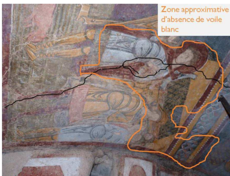
Figure 255 : Détail de la voûte de la crypte : fissure (en noir) et zone "saine", non recouverte de voile blanc
