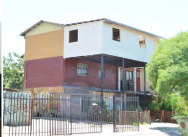
Expansions « parasite » de logement social, commune de Lo Prado
