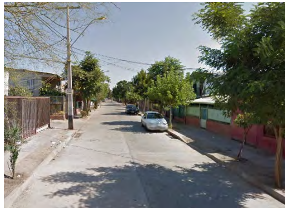
Rue Los Retamos, collecteur d'eaux pluviales et système d'égouts
