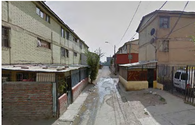
Población Valenzuela Llanos, commune de Lo Espejo. Extensions illégales des logements, voies réduites (1)
