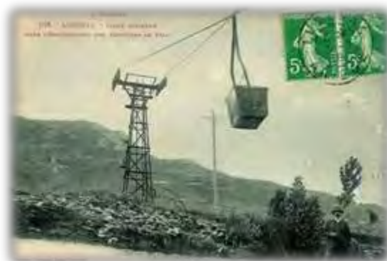
Figure I-6 : Le premier téléphérique à Luzenac.
