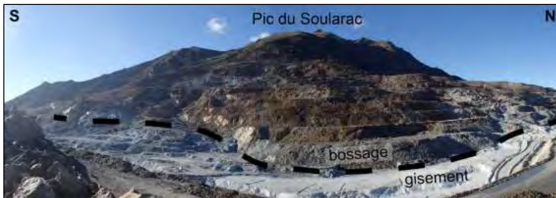
Figure I-18 : Vue du mur de Trimouns depuis le « toit ».
