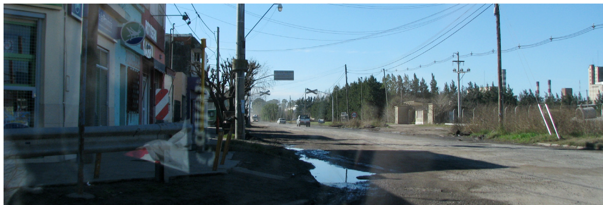
Foto 37. Ruta 188 en San Nicolás, acceso al puerto. Massin, 2012
