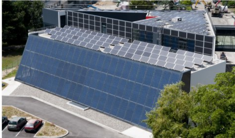
FIGURE 1.6: Façade et toit photovoltaïque du bâtiment Adream
