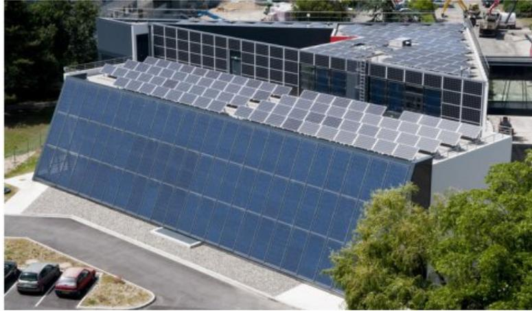
FIGURE 1.6: Façade et toit photovoltaïque du bâtiment Adream
