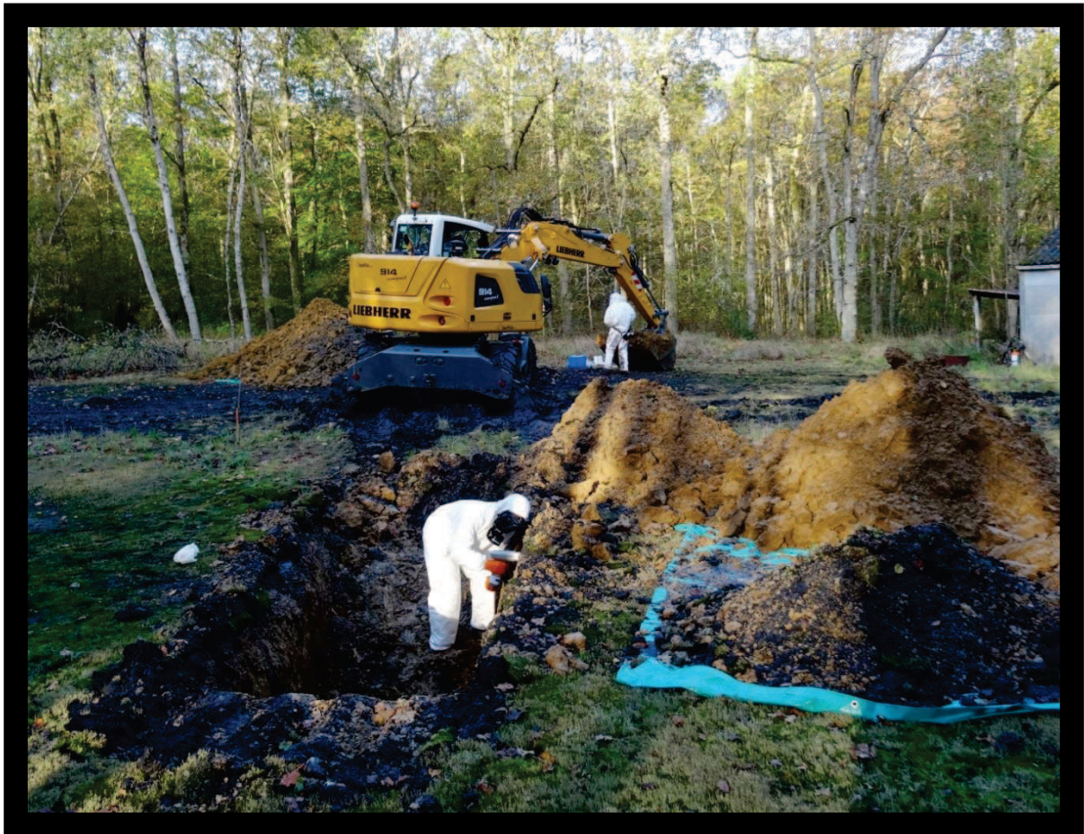
Mesures de terrain et échantillonnage sur le site de la Place-à-Gaz
