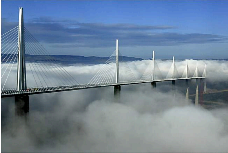
Figure I. 8 : Viaduc de Millau
