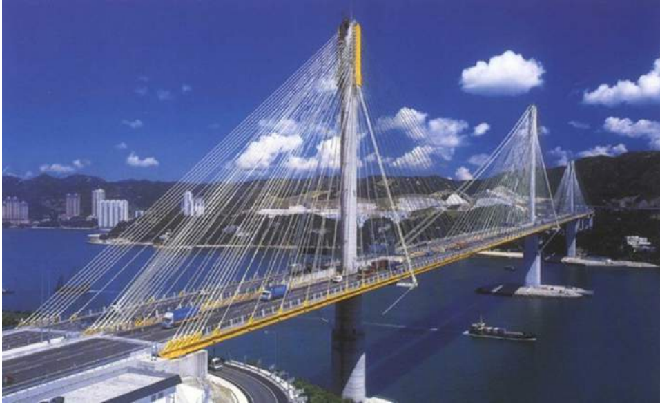
Figure I. 5 : Le pont « Ting-Kau » à Hong Kong
