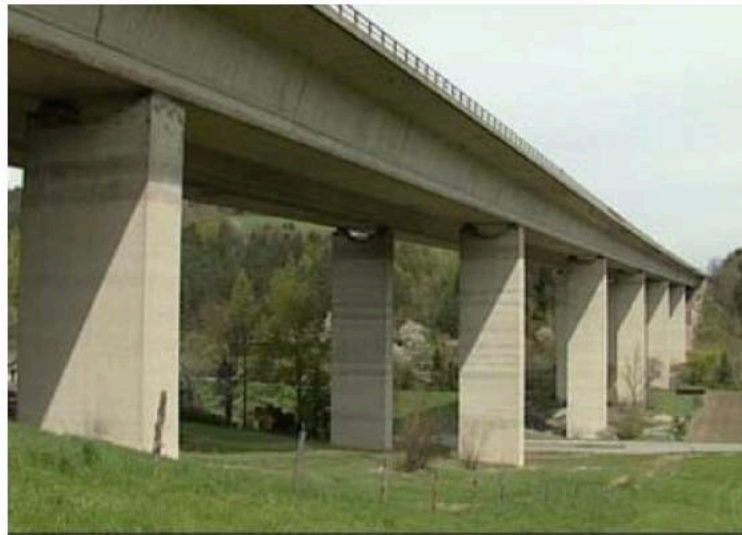
Figure I. 6 : Le pont « Warth Talübergang », Autriche
