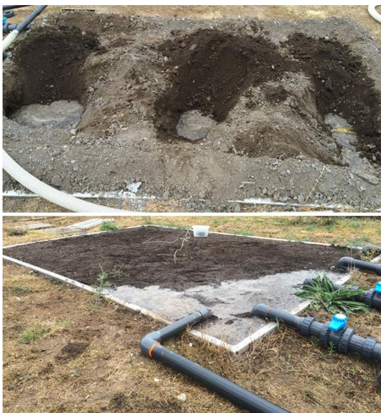
Figure 54 : Répartition homogène de l'oxydant à mi-hauteur (en haut) mais hétérogène en surface (en bas)
