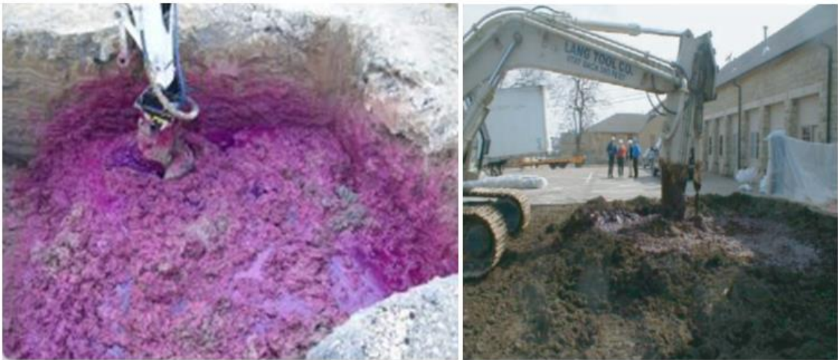
Figure 16 : Exemples de « soil mixing »
