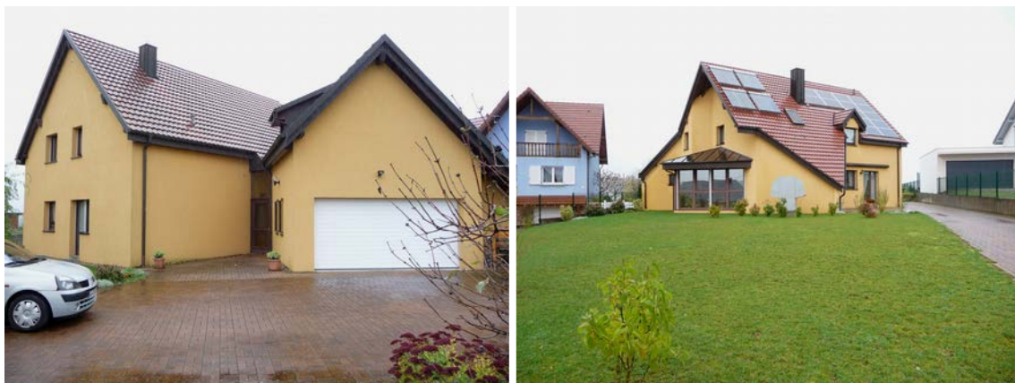
Figures 60 et 61 : Maison « géobiologique » à Oberhaslach, vue de l'entrée située à l'arrière de la parcelle au Nord et vue de la maison depuis l'entrée sur le terrain au Sud
