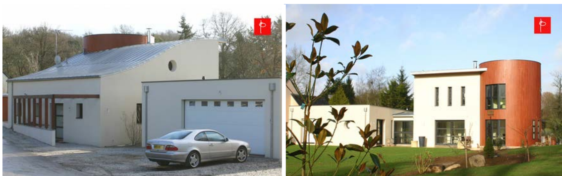
Figures 62 et 63 : Maison « fengshui » à Pontivy, vue de l'entrée côté rue au Nord et profil des quatre volumes côté jardin au Sud
