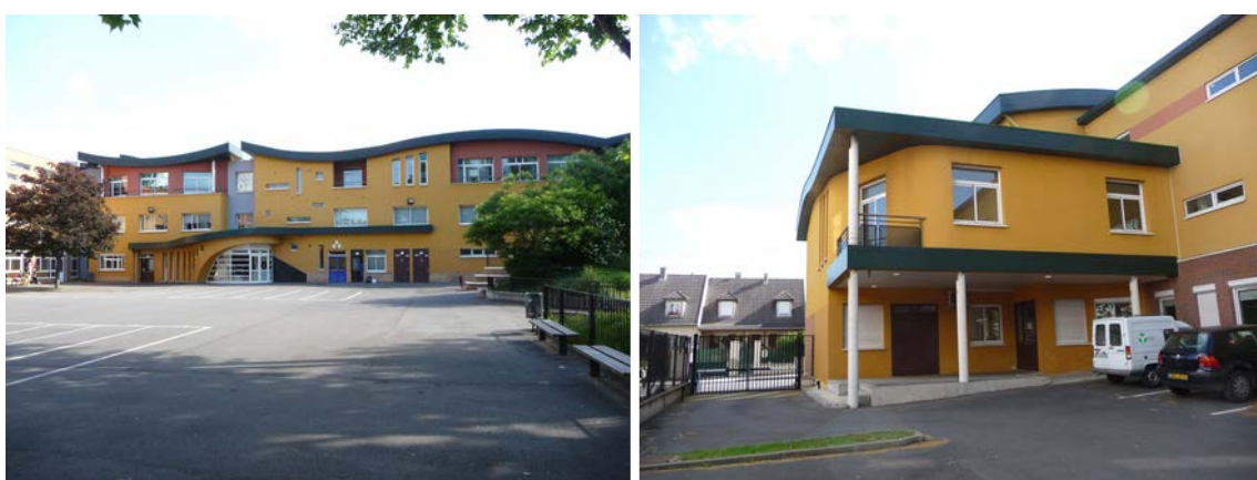
Figures 74 et 75 : Collège réhabilité « fengshui » de Pantin, vue de l'extension côté cour et sa jonction avec le volume existant
