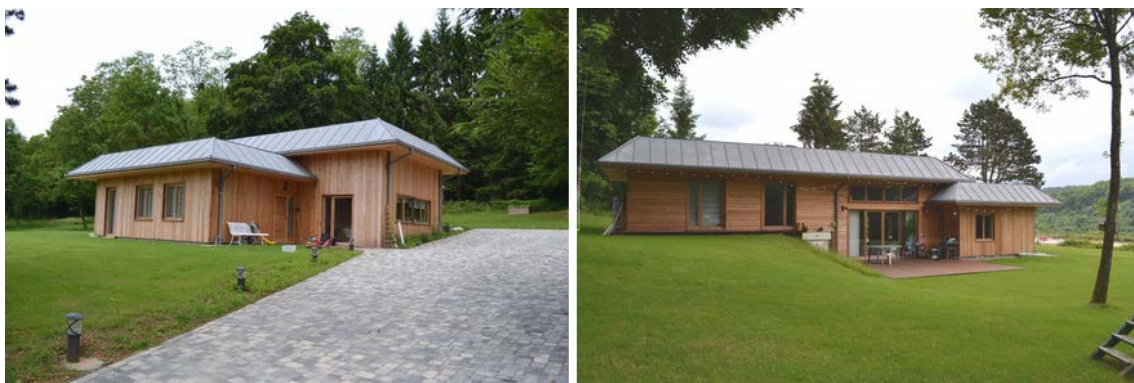
Figures 58 et 59 : Maison « démarche environnementale » à Villey-le-Sec, vue depuis le chemin d'accès au Sud et terrasse donnant sur la forêt à l'Ouest
