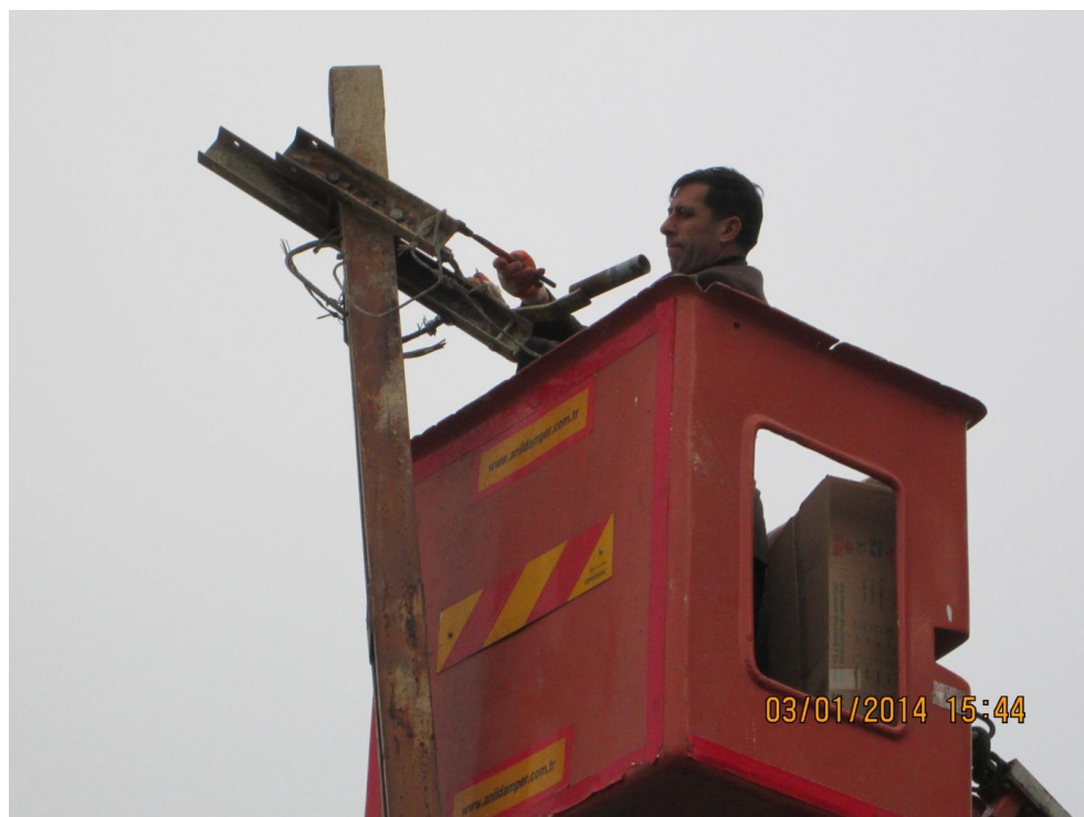
Le Muhtar répare un lampadaire. Photo prise par l'auteur 03.01.2014.
