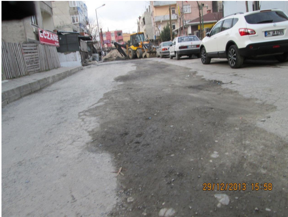
Travail d'aménagement (canalisation) à Şahintepe. Photo prise par l'auteur 29.12.2013
