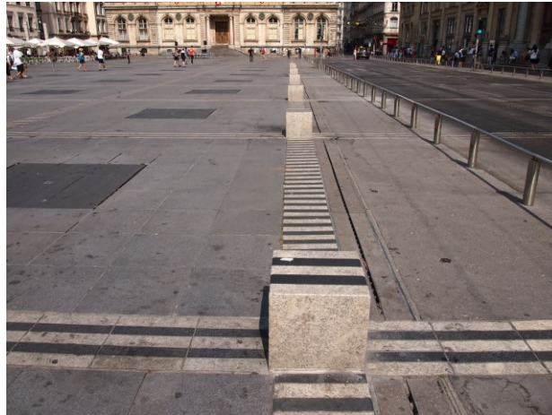
Figure 11- La métrique de la place des Terreaux : trame, fontaines, cubes et garde-corps (juillet 2013)
