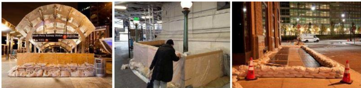
Figure 7. Protection des émergences avant la tempête. Octobre. 2012.
