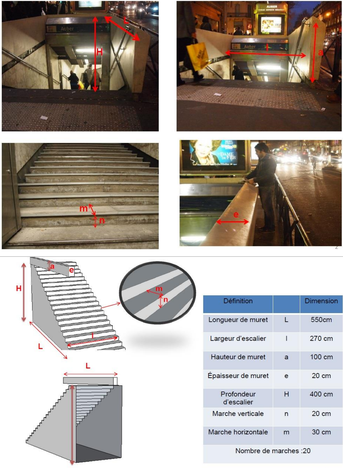
Figure 13. Modèle réel de débouché d'escalier Havre Caumartin métro de paris ligne 9 et ses dimensions géométriques.
