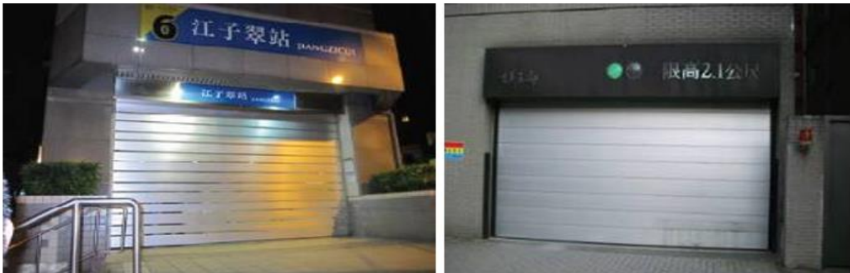
Figure III.E.11. Système de protection par portail automatique étanche.
