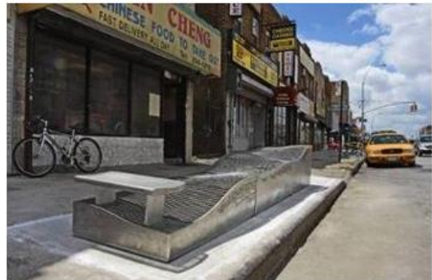
Figure III.E.10. Surélévation des grilles de ventilations dans le réseau de métro de New York.
