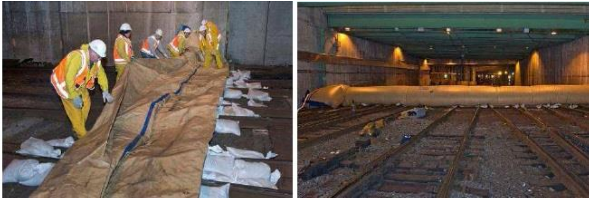
Figure 8. Mise en place de la protection gonflable.
