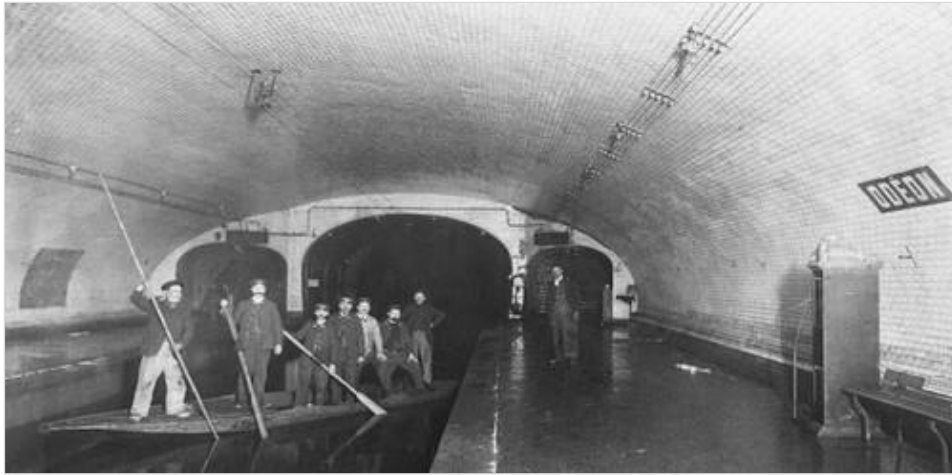
Figure 6 : Station Odéon inondée en 1910.
