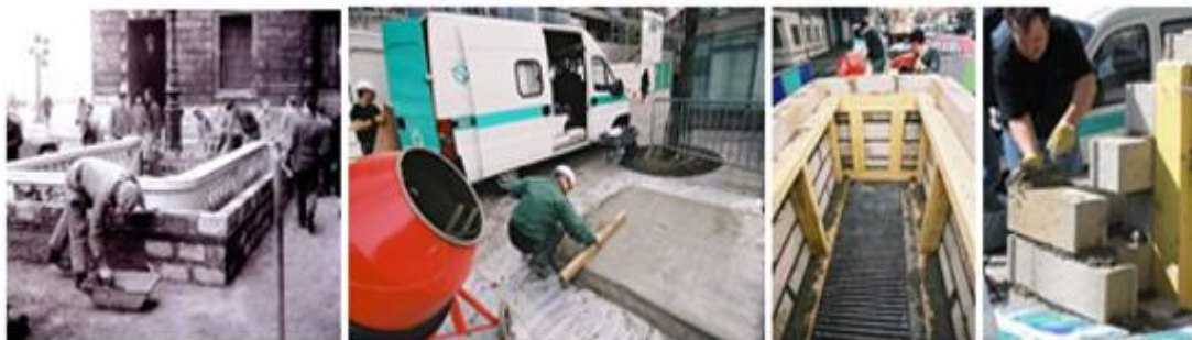
Figure III.E.6. Murs de parpaing autour des émergences.
