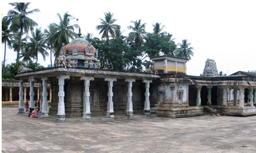
FIGURE 7.2 – Face sud de la chapelle de Campantar, vue de l'intérieur de l'enceinte, Cīkāli (cliché U. VELUPPILAI, 2006).
