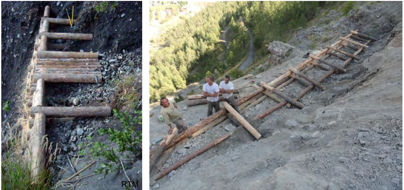
(a) Ouvrage à simple paroi stabilisé par des tirants. Crédit : RTM.
