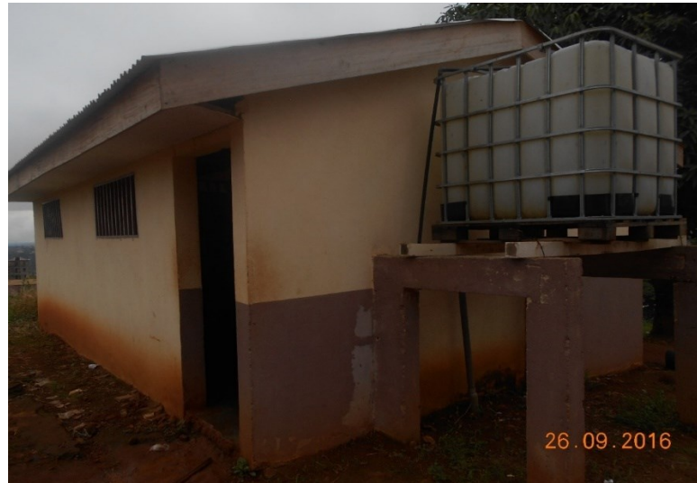
Figure 64 : Construction de nouveaux sanitaires
