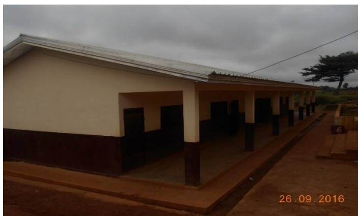
Figure 61 : Construction d'un nouveau bâtiment de 3 salles de classe
