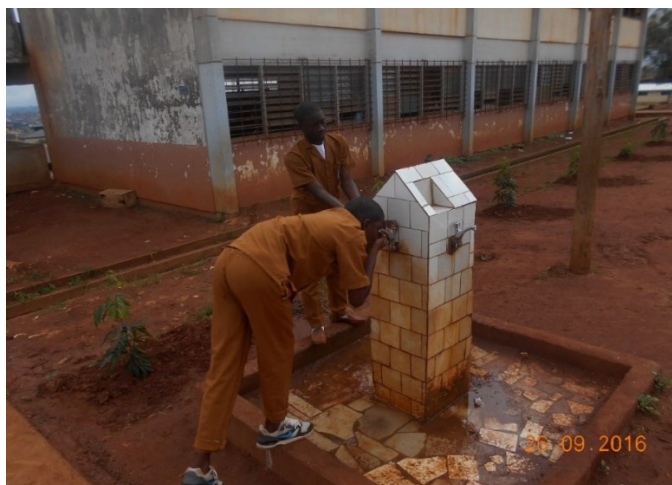
Figure 67 : Construction de fontaine pour l'accès à l'eau potable dans un établissement
