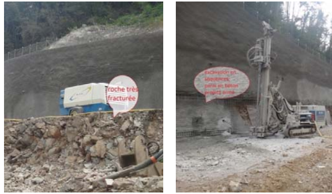
Figure 5 Confortement d'une paroi rocheuse très fracturée (RD 91, Isère)
