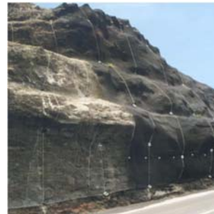
Figure 7 Filet/grillage plaqué ancré (CEMAGREF, 2004)
