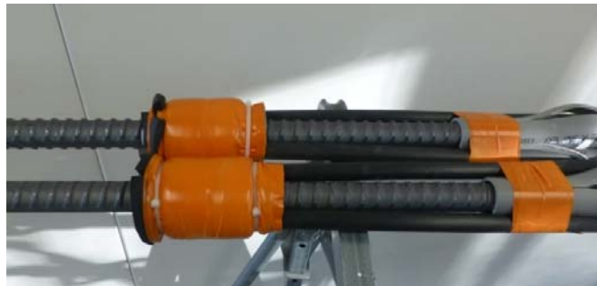
Figure 175 Barre d'ancrage équipée de canules d'injections
