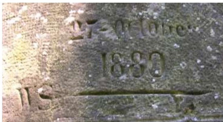
Figure 81 : Repère de crue sur la Largue à Manspach (Photo L. With)
