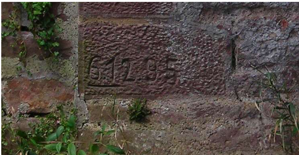
Repère de crue du 6 décembre 1895, figurant sur la pile du pont de la gare à Guebwiller (Photo : L. With)
