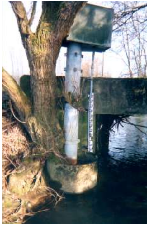
Figure 94 : Station automatique sur la Largue à Friesen (Photo L. With)
