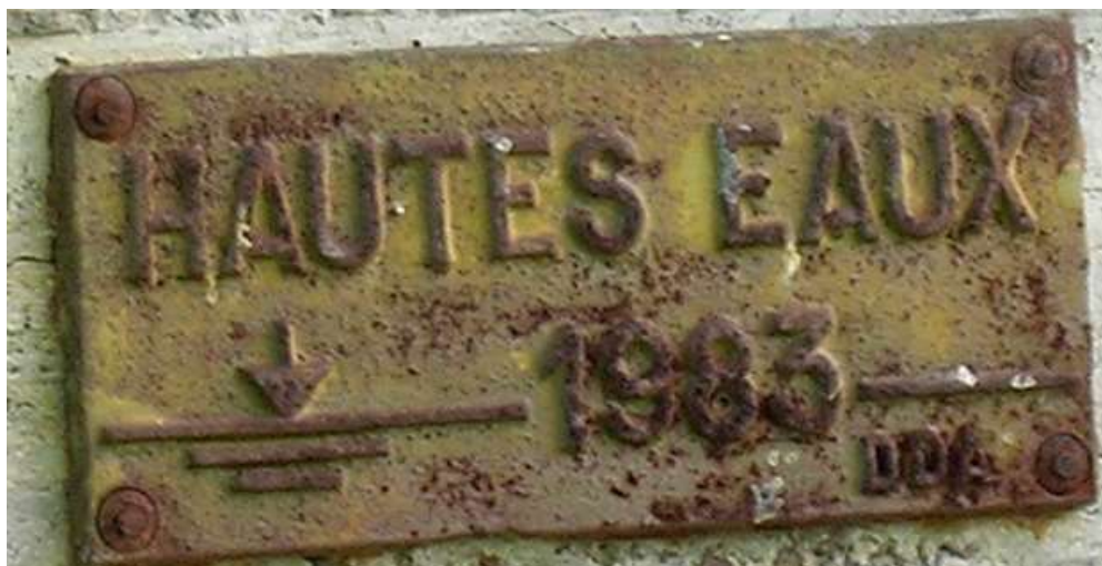
Plaque-repère sur le pont d'Altenach-Vallée de la Largue (Source : Photo L. With)
