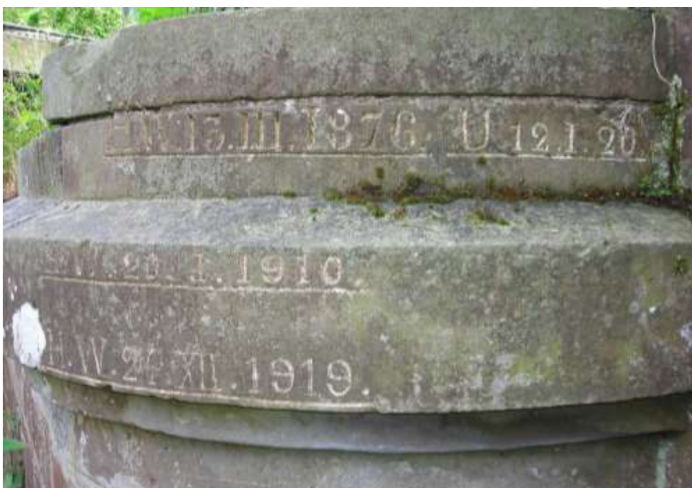
Figure 37 : Repère de crue au pont de la Lauch à Colmar-Neuland (Photo L. With)
