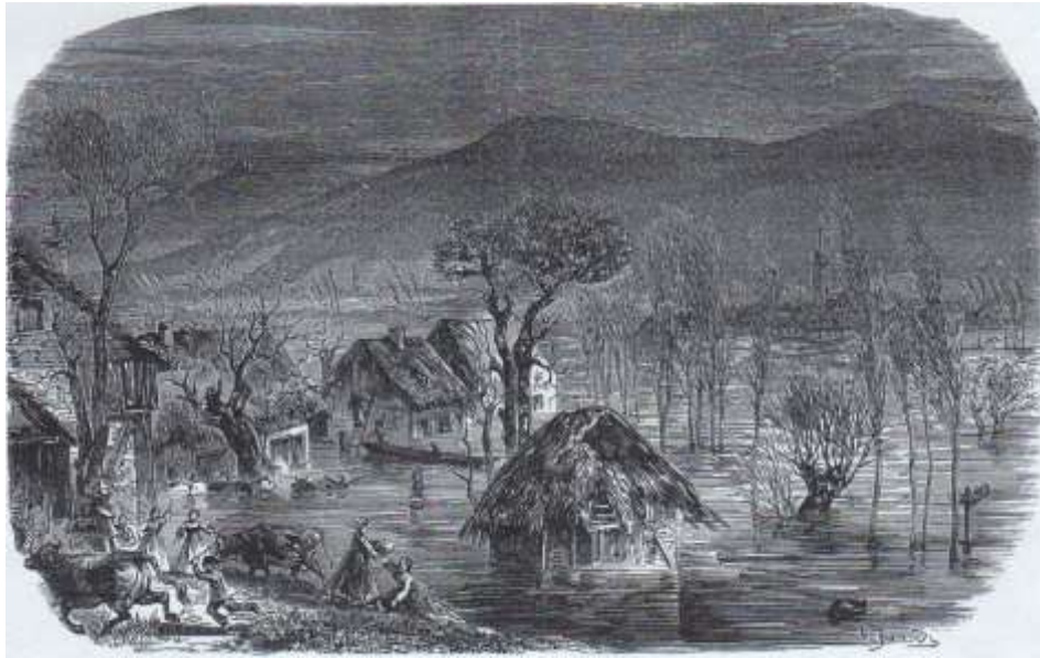
Figure 77 : Débordement de l'Ill en février 1860 - Inondation du village d'Illfurth (Haut-Rhin), d'après un croquis envoyé par Jundt, ingénieur à Mulhouse (Source : http://www.meteo-paris.com/chronique/annee/1860-1869 )
