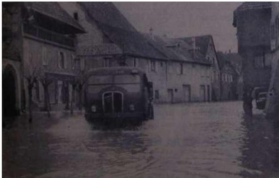
Rue Lefebvre à Rouffach sous 60 cm d'eau ( L'Alsace des 16-17/01/1955)
