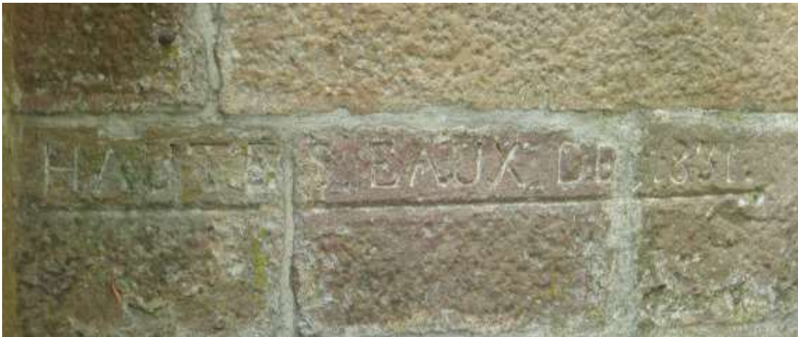
Figure 107 : Repère de crue de septembre 1831 au pont d'Issenheim (centre-ville) (Source : Phot L. With)
