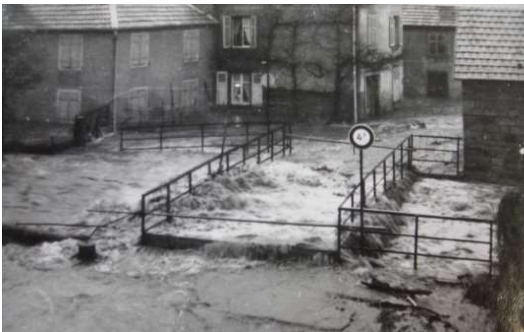
Figure 61 : Pont sur la Lauch à Buhl en décembre 1947
