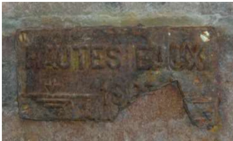
Figure 106 : Un repère de crue de 1983 en mauvais état sur l'Ill à Horbourg-Wihr (Photo : L. With)
