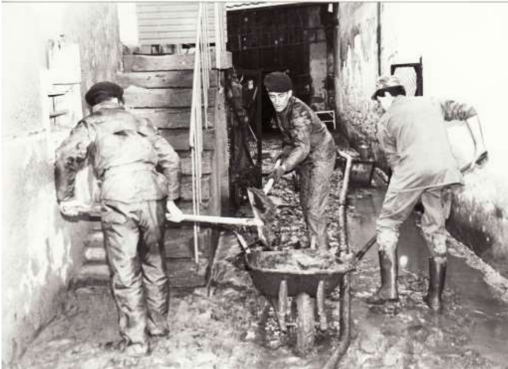
Nettoyage à Guebwiller après les inondations de février 1990 (Source : AMG 13 W 10)
