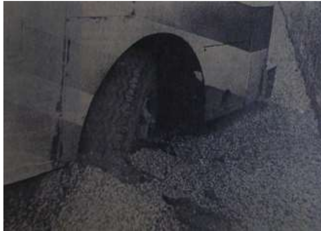
Chaussée en mauvais état – Route de Bâle à Colmar ( L'Alsace du 18/01/1955)
