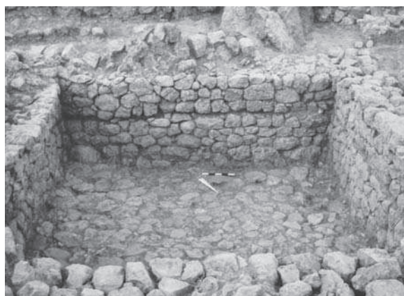
FIGURE 96 – Vue sur le mur sud, où l'interstice entre deux assises de pierres indique la présence de chaînage.
