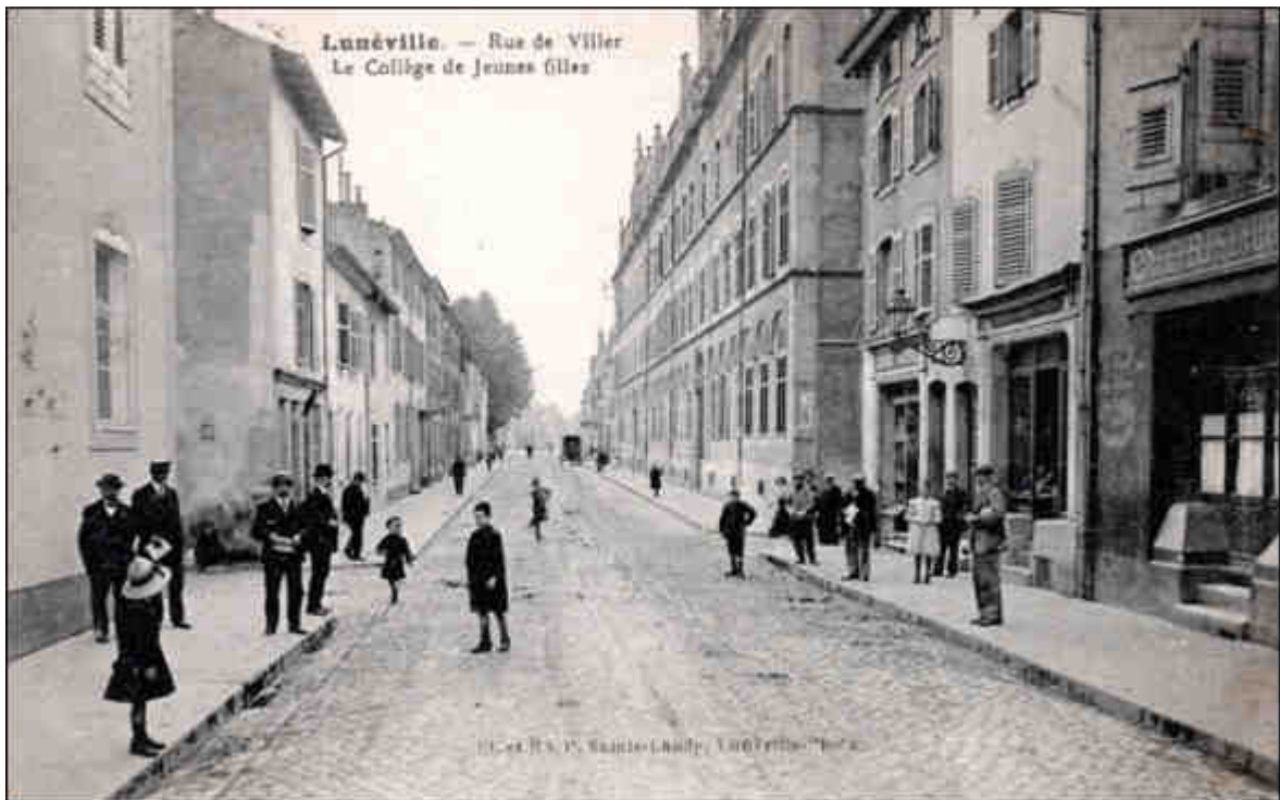
Figure 166 : Photographie du bâtiment accueillant les cours secondaires de jeunes filles de Lunéville à partir de 1925, puis le collège de jeunes filles : prise de vue d'un côté de la rue (carte postale, début XX e siècle, coll. part.).
