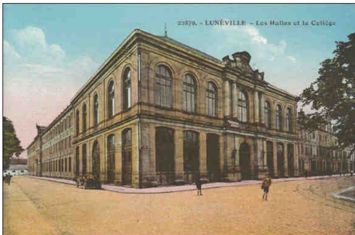
Figure 165 : Photographie des halles de Lunéville, au centre, et de deux parties du collège de garçons : à gauche, le nouveau bâtiment du collège ; à droite, un ancien hôtel particulier appartenant au collège et qui abrite les cours secondaires de jeunes filles de 1922 à 1925 (carte postale colorisée, début XX e siècle, coll. part.).
