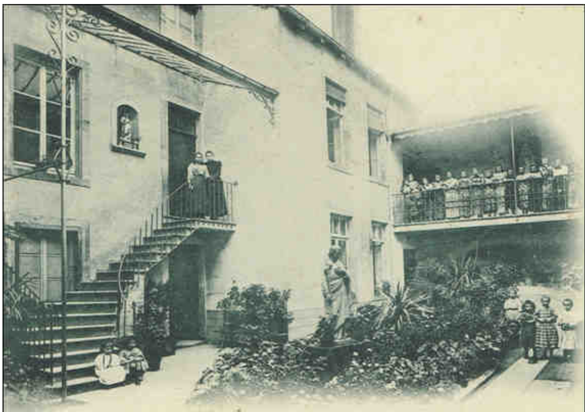
Figure 202 : Photographie du bâtiment du pensionnat des Sœurs de la Doctrine Chrétienne à Mirecourt (carte postale, vers 1900, coll. part.).
