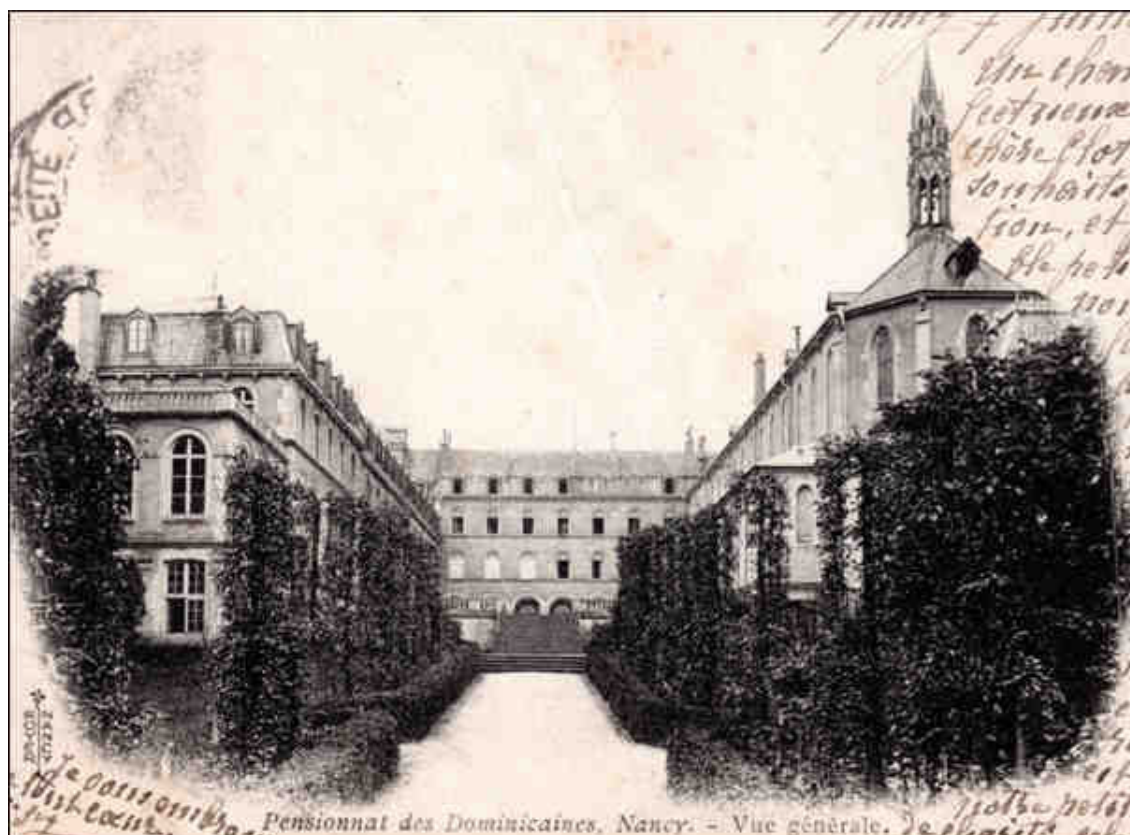
Figure 191 : Photographie du bâtiment du pensionnat du tiers-ordre de Saint-Dominique à Nancy (carte postale, vers 1900, coll. part.).
