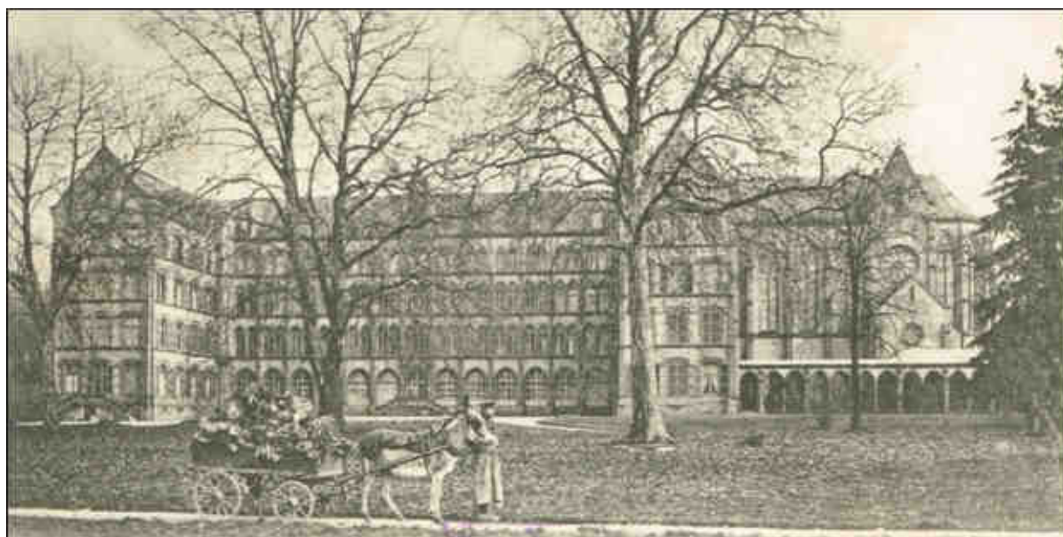
Figure 219 : Photographie du bâtiment du pensionnat des Dames du Sacré-Cœur à Montigny-les-Metz, rouvert après 1918 : une façade latérale (carte postale, début XX e siècle, coll. part.).
