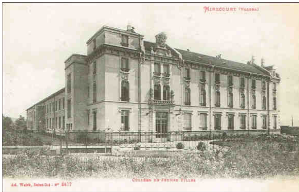
Figure 139 : Photographie du bâtiment construit en 1907 pour le collège de jeunes filles de Mirecourt (carte postale, début XX e siècle, coll. part.).
