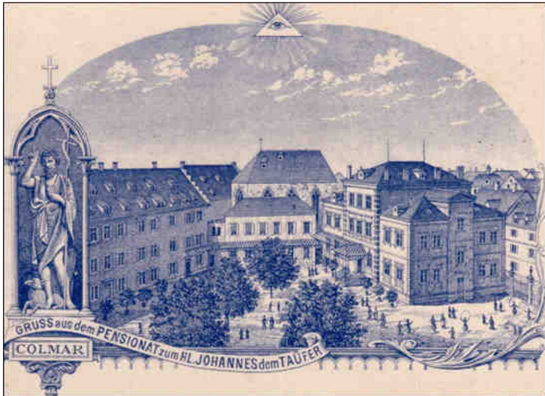
Figure 148 : Gravure des bâtiments de l'école supérieure de filles des Sœurs de la Divine Providence de Ribeauvillé à Colmar, avec, à droite, le bâtiment construit en 1896 (carte postale, vers 1900, coll. part.).
