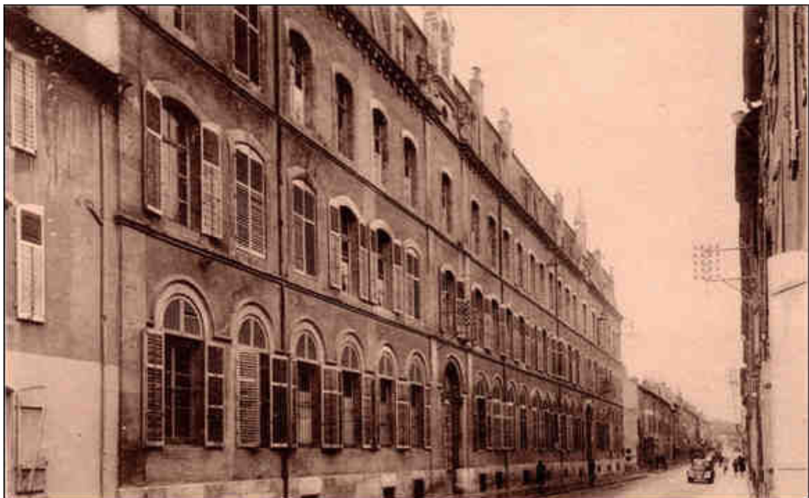
Figure 167 : Photographie du bâtiment accueillant les cours secondaires de jeunes filles de Lunéville à partir de 1925, puis le collège de jeunes filles : prise de vue de l'autre côté de la rue (carte postale, début XX e siècle, coll. part.).
