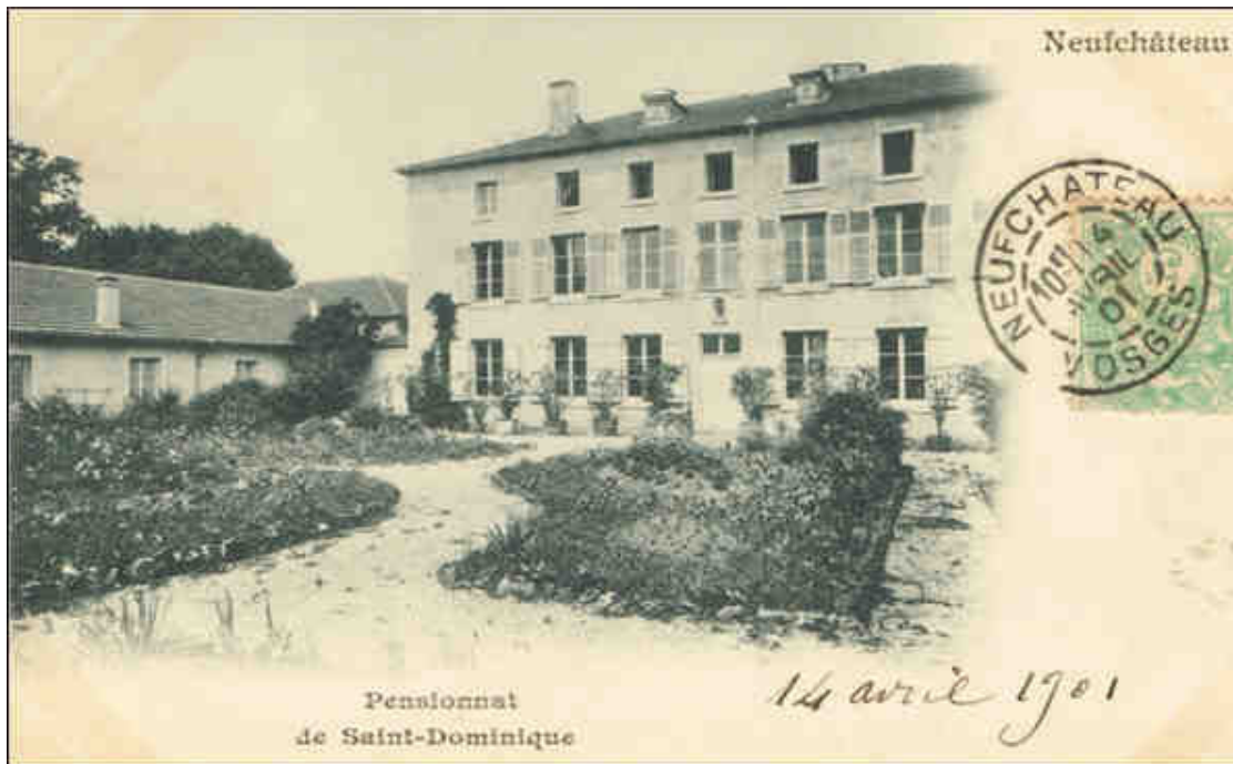
Figure 194 : Photographie du bâtiment du pensionnat du tiers-ordre de Saint-Dominique à Neufchâteau (carte postale, vers 1900, coll. part.).
