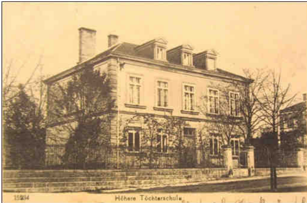
Figure 129 : Photographie du bâtiment construit en 1888 pour l'école subventionnée supérieure de filles de Sarrebourg (carte postale, vers 1900, AMSar 4Fi221).
