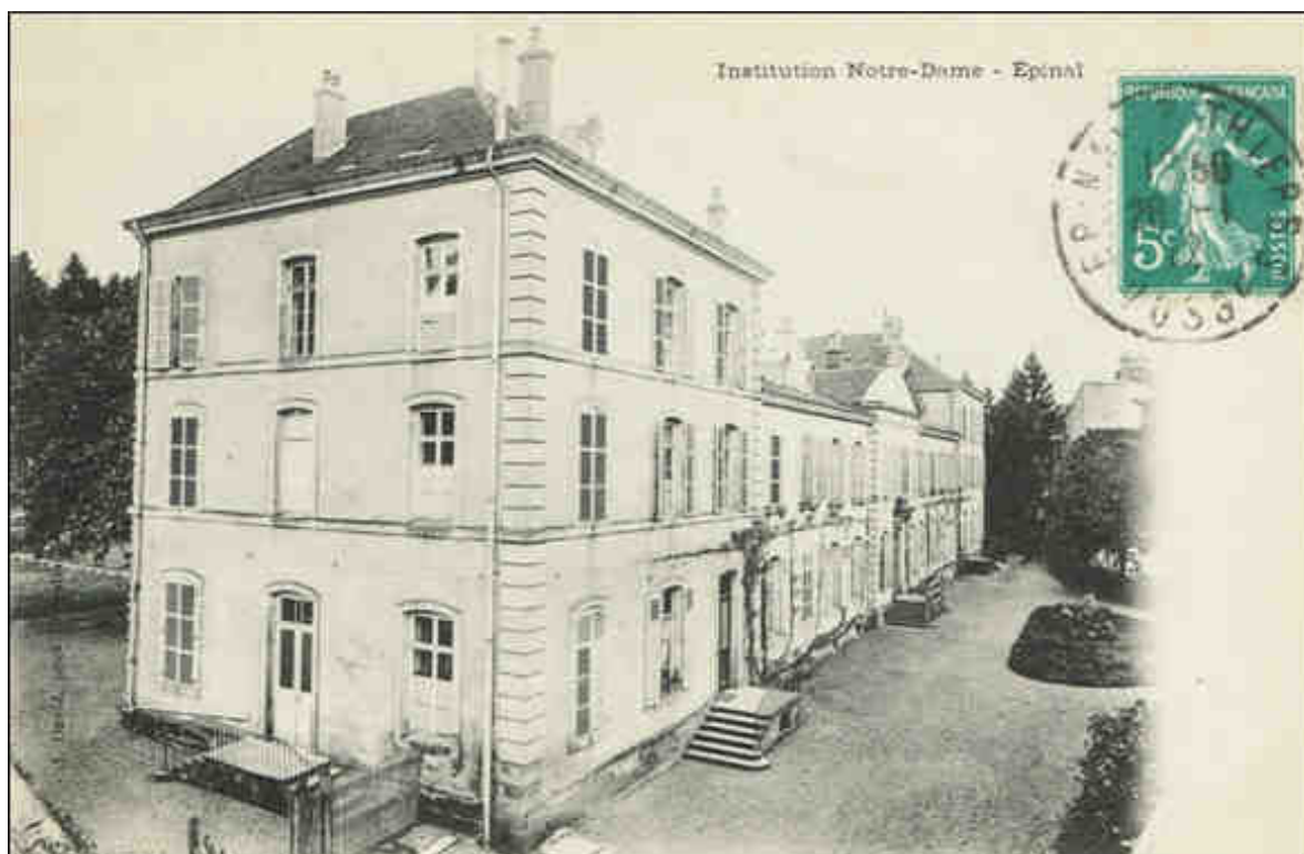
Figure 196 : Photographie du bâtiment du pensionnat des chanoinesse augustines de Notre-Dame à Épinal (carte postale, vers 1900, coll. part.).
