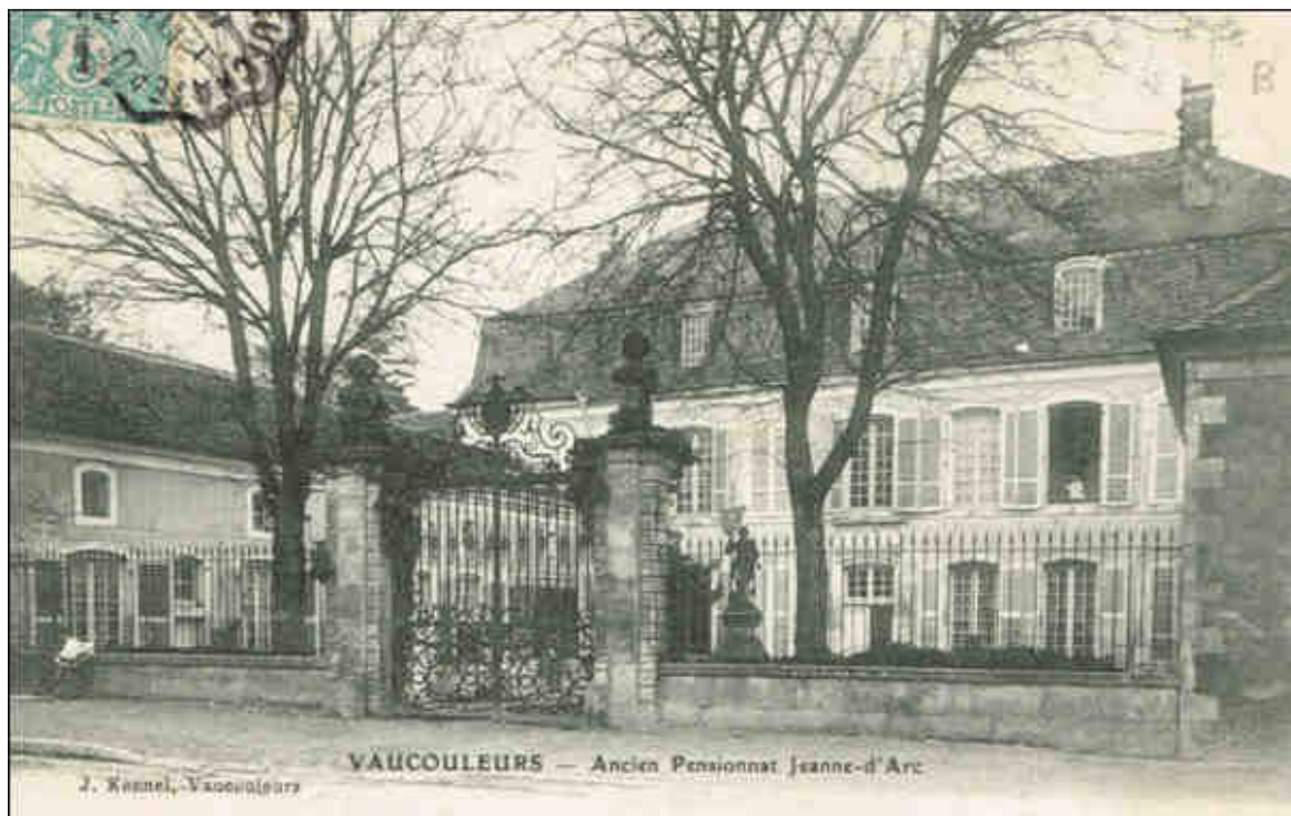
Figure 207 : Photographie du bâtiment du pensionnat des Sœurs de la Compassion de Saint-Hilaire à Vaucoeurs (carte postale, début XX e siècle, coll. part.).
