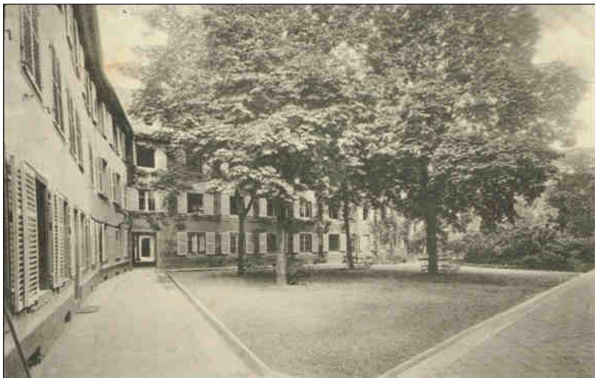
Figure 151 : Photographie du bâtiment construit en 1879 pour l'école supérieure de filles du Bon-Pasteur à Strasbourg (carte postale, vers 1900, coll. part.).
