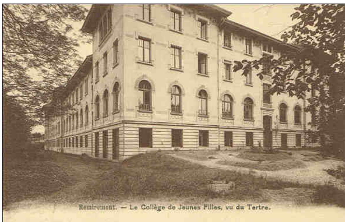
Figure 144 : Photographie du bâtiment construit en 1913-1914 pour le collège de jeunes filles de Remiremont (carte postale, début XX e siècle, coll. part.).
