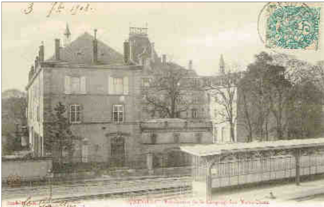
Figure 195 : Photographie du bâtiment du pensionnat des chanoinesses augustines de Notre-Dame à Lunéville (carte postale, vers 1900, coll. part.). Le prieuré du XVIII e siècle a été augmenté d'une aile Ouest (à droite) et d'une nouvelle chapelle en 1877, d'un étage de combles et d'un habillage en grès des trois travées centrales en 1895 7485 .
