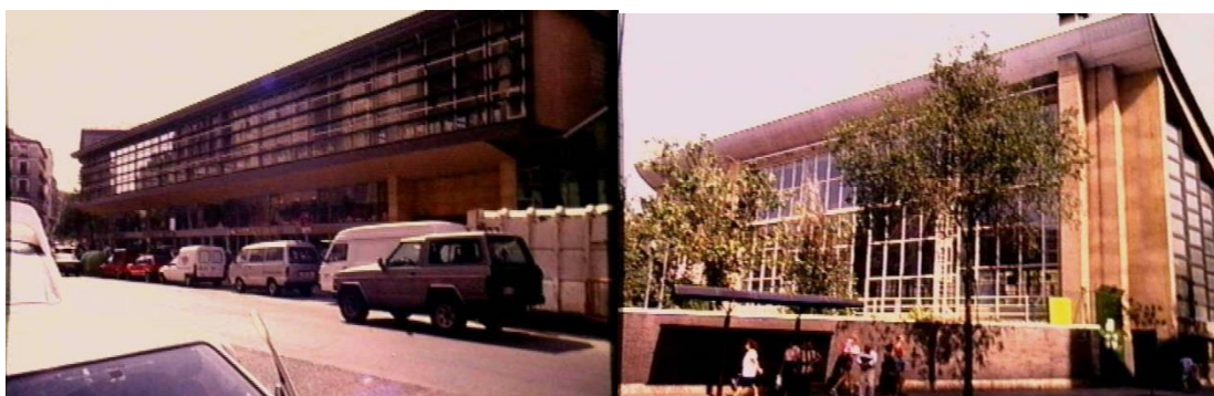
Figure 69 : Les installations sportives démolies 181
