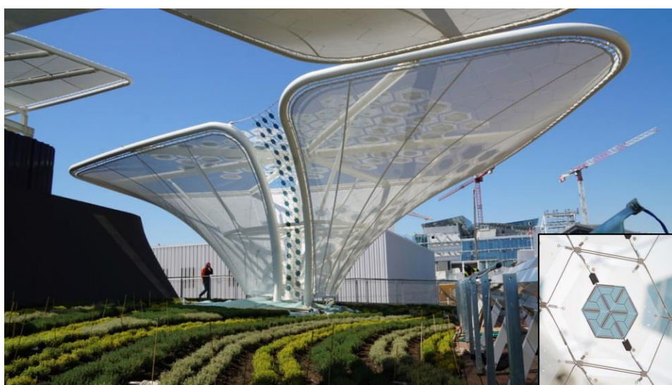
Figure 5 : Arbre solaire de l'exposition universelle de Milan réalisé par Merck, en incrustation un exemple d'un module photovoltaïque composant l'arbre solaire.
