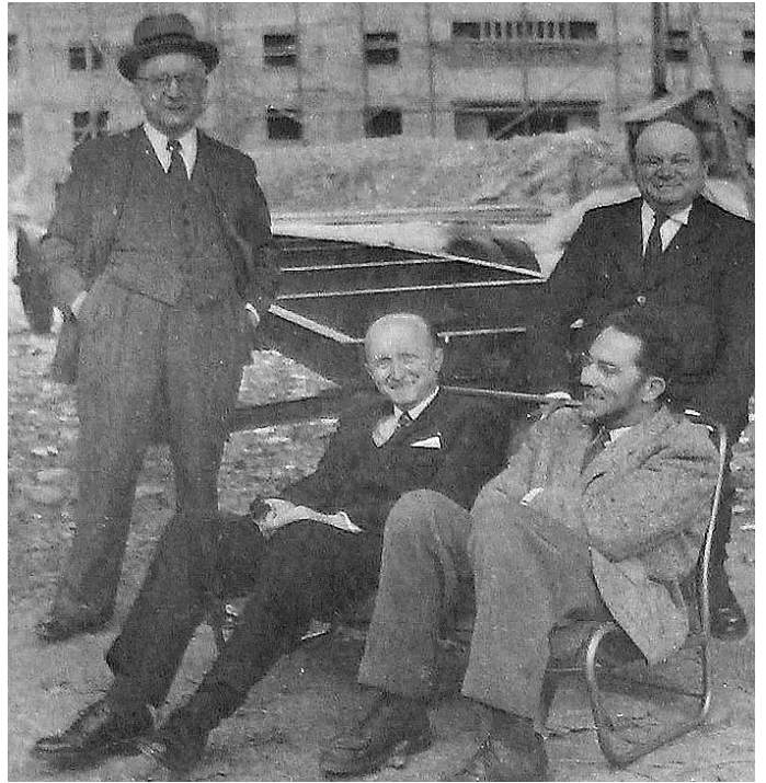
III.013: Stoskopf et Oehler en 1952 devant le chantier du quai des Belges / ADBR60J1, anon.
