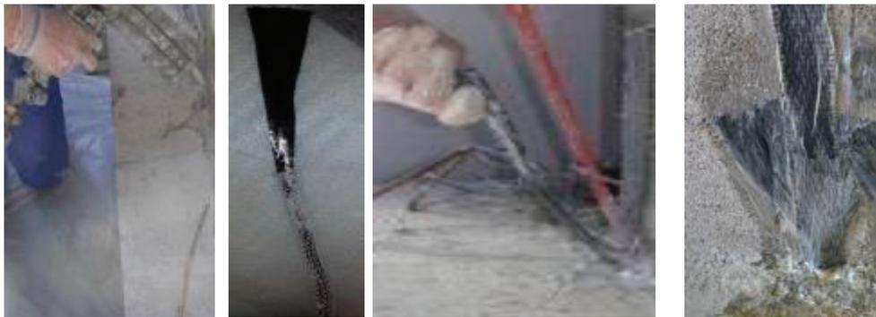
**Figure 3-12 : Procédure de mise en œuvre des ancrages MAPEI**
