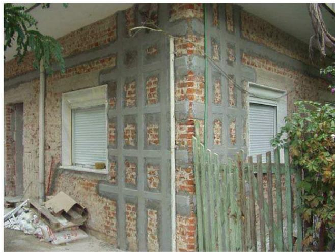
**Figure 0-5 : Exemple de renforcement des bâtiments en maçonnerie par FRP [Sika limited (2003)]**
