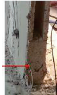
L'écrasement de la brique du côté droit
