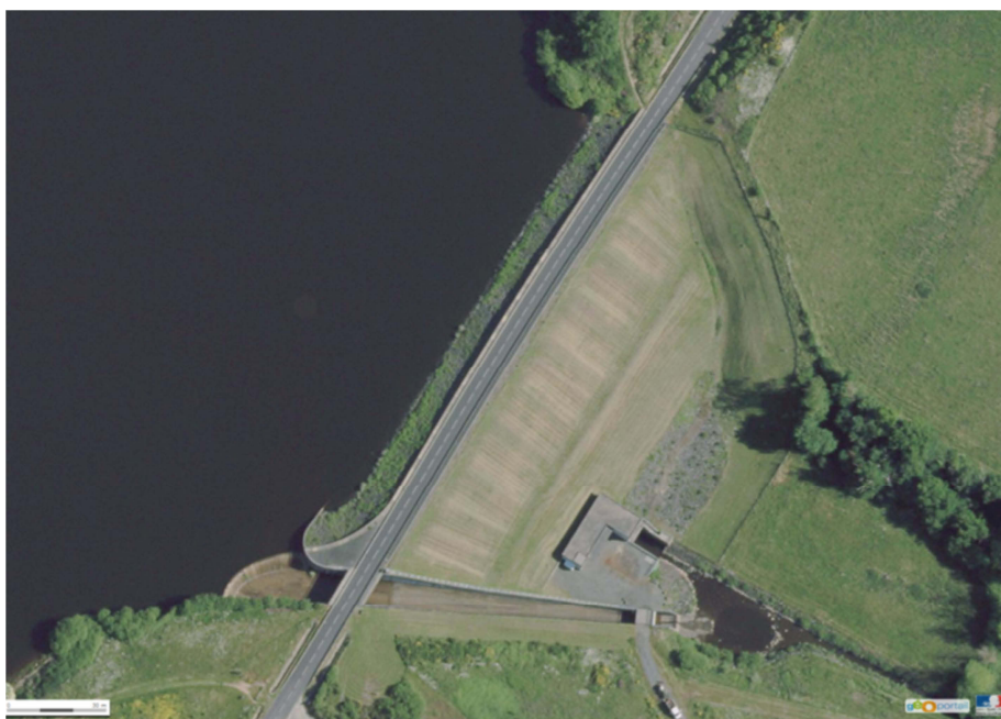
Figure I. 18 Vue aérienne du barrage de la Sillonnière
