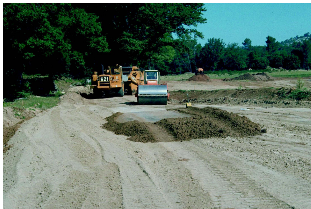
Figure I. 4 (à g.) Planche d'essai (Degoutte, 2002); (à d.) Gammadensimètre (Durand et al., 1999)
