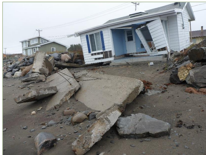
Figure 6: Résidence secondaire endommagée suite aux tempêtes de 2010 (Sainte-Luce, 15/05/2013).
