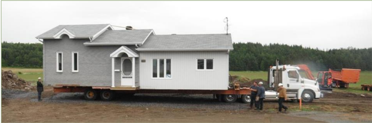
Figure 3: déplacement d'une habitation au Québec après les tempêtes de 2010 (source: MSP).
