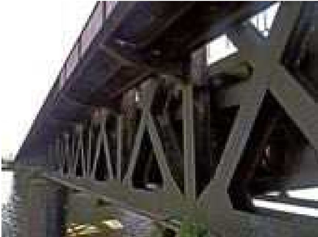
FIGURE 4.3 – Le pont sur l'Adour. Photo prise le 3 avril 2013 lors de la visite technique de sélection de pièces à récupérer lors de la démolition.
