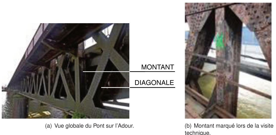
FIGURE 4.5 – Repérage des pièces en fer puddlé à récupérer (Pont sur l'Adour).
