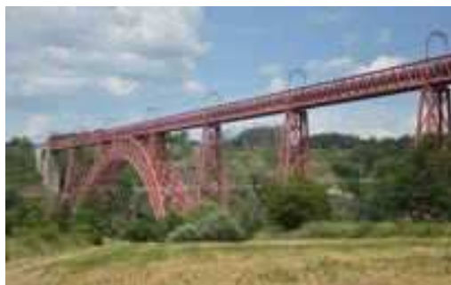
(b) Le viaduc de Garabit dans le Cantal.
