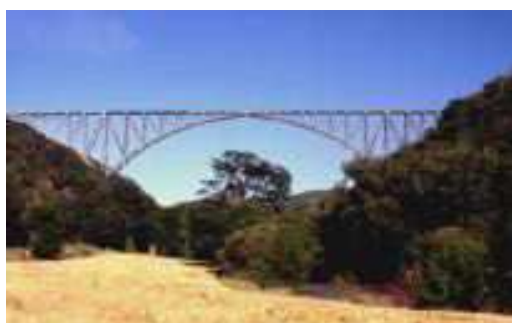
(c) Le Viaduc de Vaur en Aveyron.
