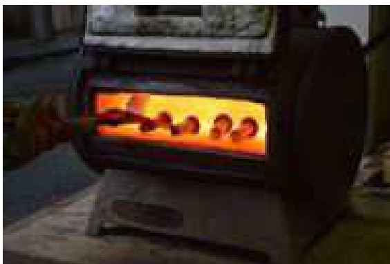
FIGURE 2.10 – Échauffement de quatre rivets dans un four de chantier à 980^\circ\text{C} .
