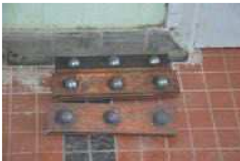
FIGURE 6.9 – Triplures de référence exécutées par l'équipe de rivetage de SNCF Réseau.
