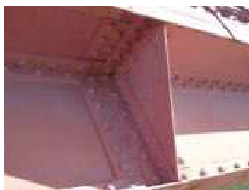
(d) Assemblage d'une équerre par cornières.
