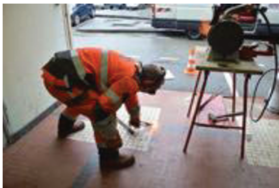
FIGURE 2.11 – Rivet frappé au sol afin de le débarrasser au mieux de la calamine qui le recouvre.
