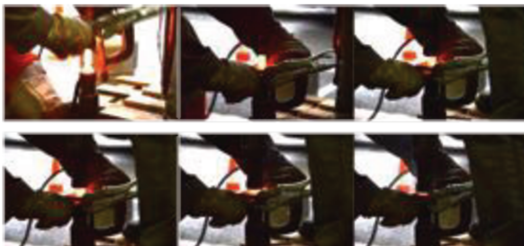
FIGURE 2.13 – Séquence de martelage du rivet.
