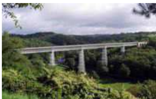
(d) Le Viaduc de Busseau dans la Creuse.
