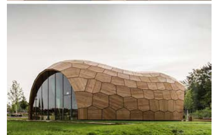
Figure 2.26 - Halle d'exposition du Landesgartenschau. Enveloppe structurelle conçue et fabriquée numériquement. D'après ICD/ITKE de Stuttgart.
