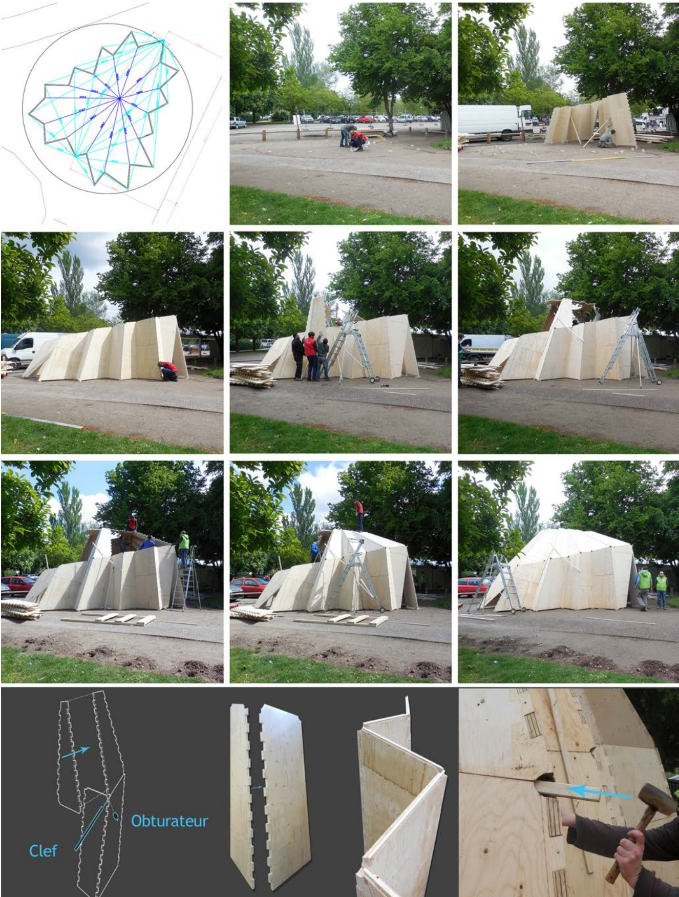
Figure 3.16 - Montage de la New-Yourte.
