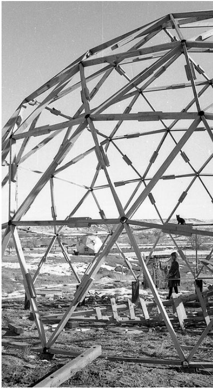
Figure 3 - Le dôme géodésique (cf. Buckminster Fuller et Steve Baer) permet de construire des structures peu coûteuses, notamment avec l'emploi de matériaux de recyclage; Drop City, 1965. D'après (Grossman, 2012).
