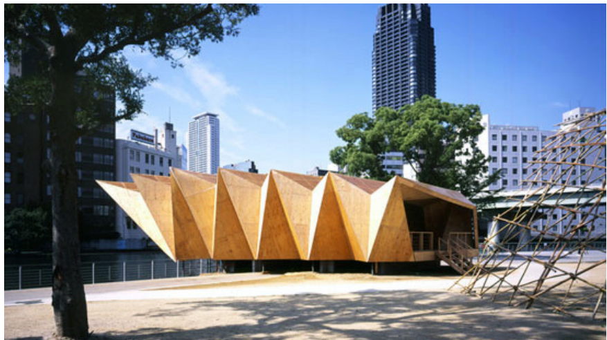
Figure 2.29 - Pavillon Temporaire. Plissage d'éléments triangulaires formant une «voûte» à deux brisis. Disponible à l'adresse : http://www.archdaily.com/44225/bamboo-forest-and-corinth-hut-18 [consulté le 15 octobre 2014]
