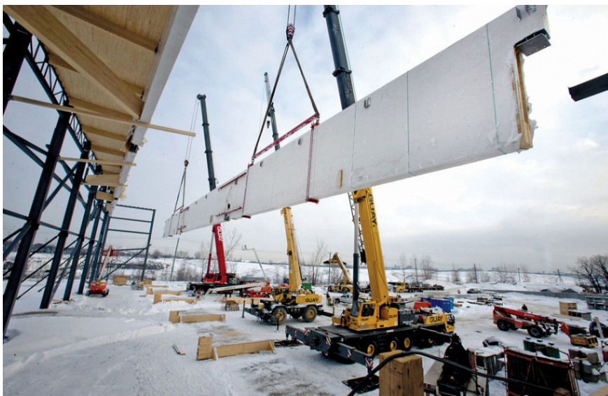
Figure A2.9 - Mise en place d'une des treize «méga» poutres en bois d'épinette noire du Centre de Soccer de Montréal. Dimensions : 70 m de longueur, 4 m de hauteur et pèse 125 tonnes.
