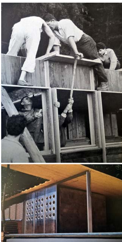
Figure 2.22 - Mise en œuvre des panneaux courbes de la toiture, maison Prouvé, Nancy. D'après (Prouvé, Stoullig, 2012).
