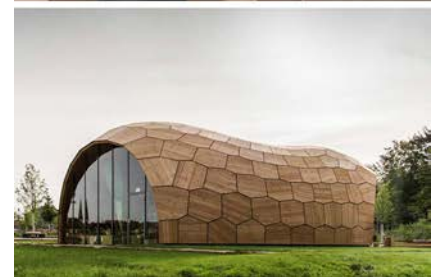
Figure 2.26 - Halle d'exposition du Landesgartenschau. Enveloppe structurale conçue et fabriquée numériquement. D'après ICD/ITKE de Stuttgart.
