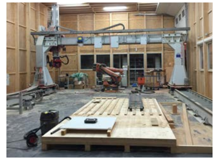
Figure 3.3 - Portique cinq axes robotisé de l'ENSTIB.
