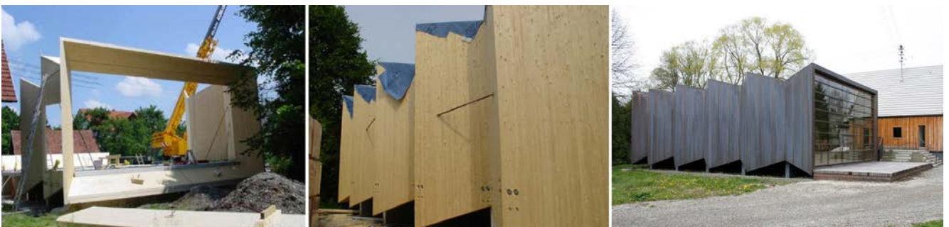
Figure 2.30 - Salle de répétition de Thannhausen. Ce plissage est constitué d'une série de plis identiques agissant comme des portiques structuraux.
