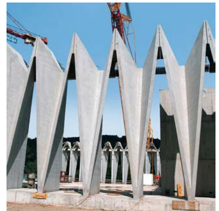
Figure 1.27 - Mise en place des éléments préfabriqués en béton, salle multisports, Windisch, Suisse, Livio Vacchini, 2005.
