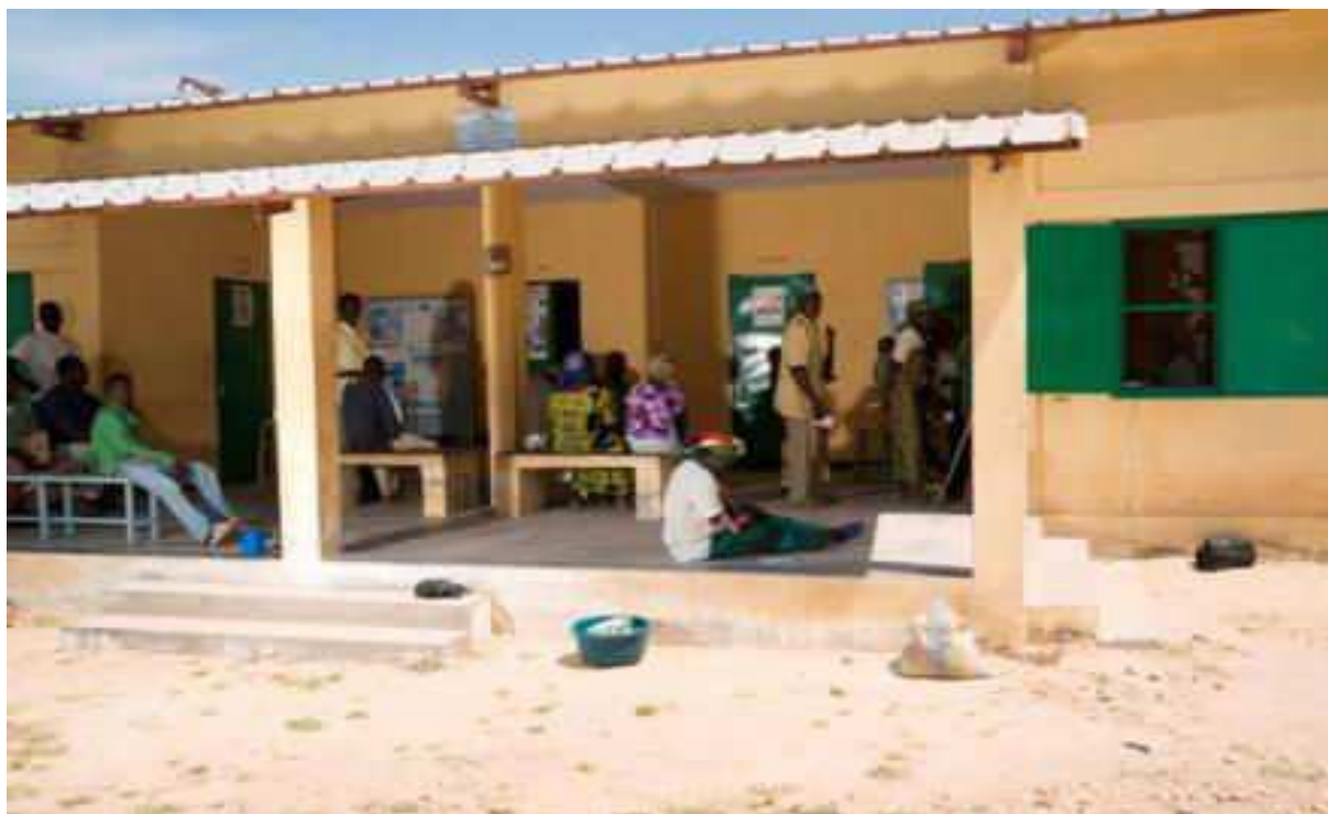
Photo 7 : Un centre de santé construit par le PRODALKA
