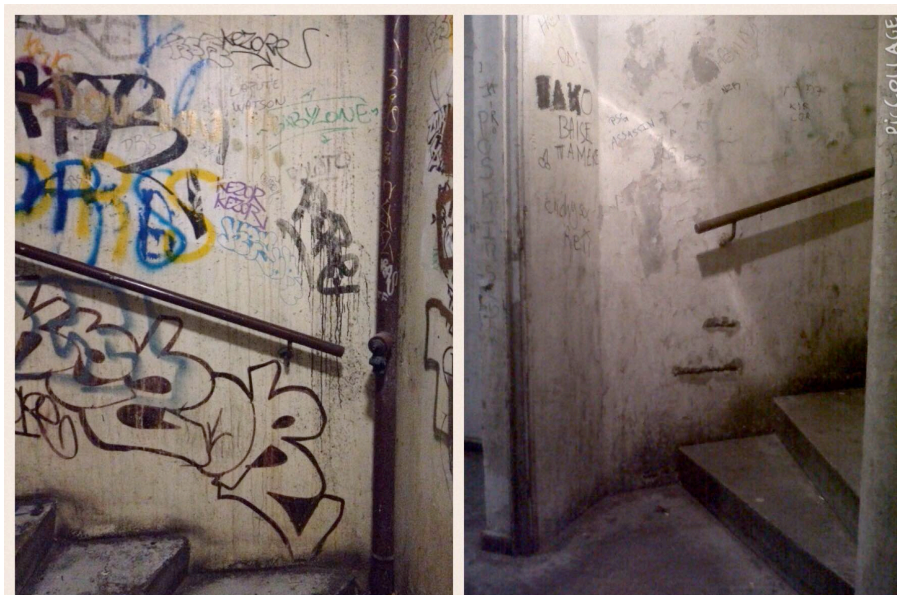
Photo 10 et 11 : La Forestière, escaliers. (Rémi Habouzit, avril 2013).
