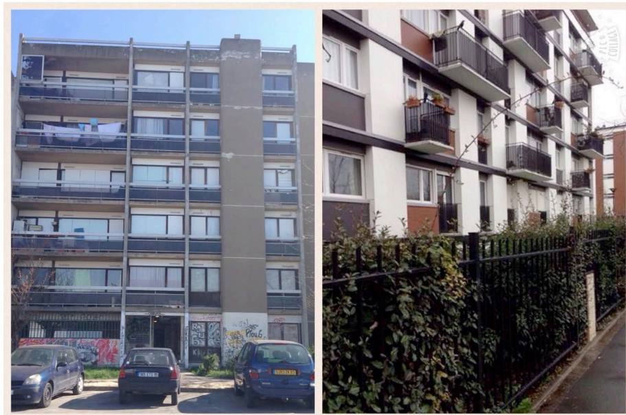
Photos 16 et 17 : Les extérieurs de la Forestière et des nouvelles constructions à Montfermeil. (Rémi Habouzit, décembre 2012).
