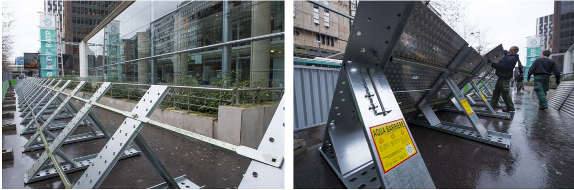
FIGURE 7.9 – Exercice de montage d'aqua-barrières ou batardeaux réalisé le 29 janvier 2013 (source : RATP)
