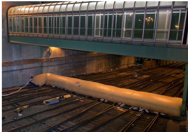
(c) Boudin gonflable utilisé au niveau du métro de New-York durant l'ouragan Sandy en 2012 (source : MTA)
