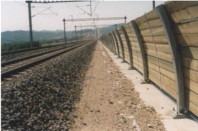
(a) Exemple de mur anti-vent positionné au niveau des zones critiques le long de la LGV Méditerranée (source : SNCF)
