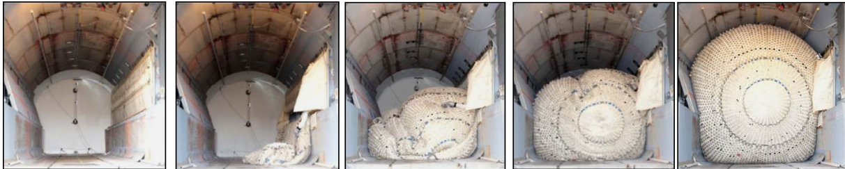
(a) « Tunnel plug » en phase de gonflage (CAMPBELL-DOLLAGHAN, 2013)
