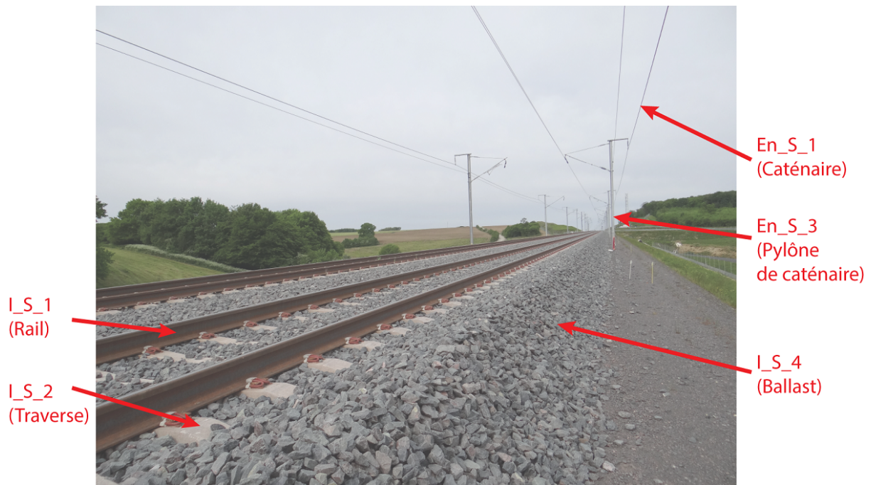
FIGURE 3.14 – Illustration sur une ligne de transport de quelques composants et de leurs identifiants respectifs (source : auteur)
