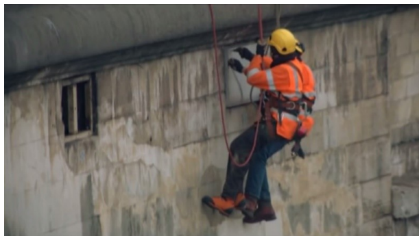
(b) Exercice de protection du RER C contre les inondations avec la mise en place de panneaux pour fermer les baies d'aération, 20 janvier 2016
