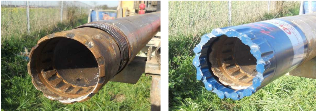
Figure 5. Mise en place de la trousse coupante à dépassement variable (à gauche) et installation de la couronne rotative (à droite)
