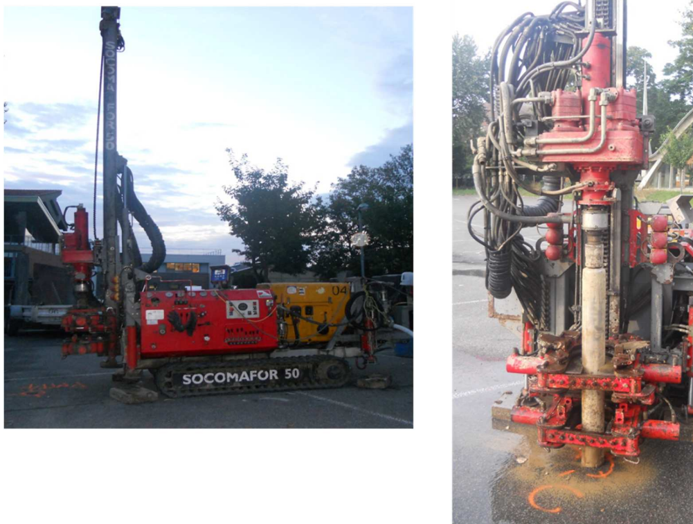
Figure 4.23 Machine de forage employée dans le cadre des expériences géotechniques in situ sur le site de Cachan
