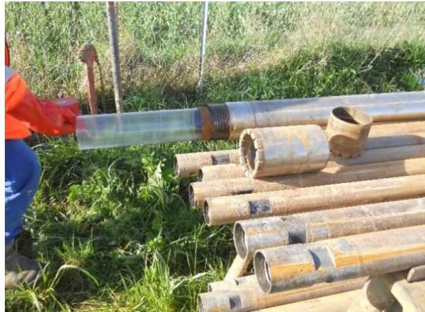
Figure 4. Insertion de l'étui en PVC à l'intérieur du carottier double en le transformant en carottier triple
