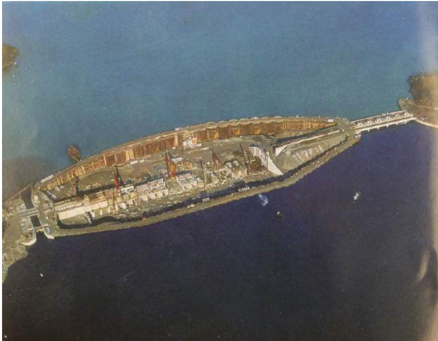
FIGURE 36. Travaux à sec de la marémotrice après la coupure de la Rance le 23 juillet 1953
