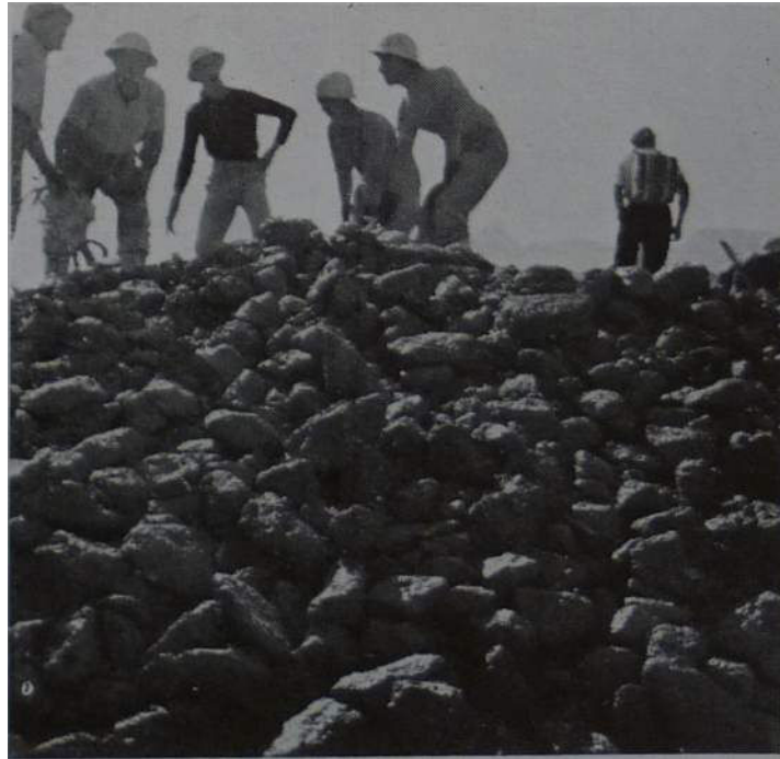
FIGURE 9. Mise en place du béton par pervibration
