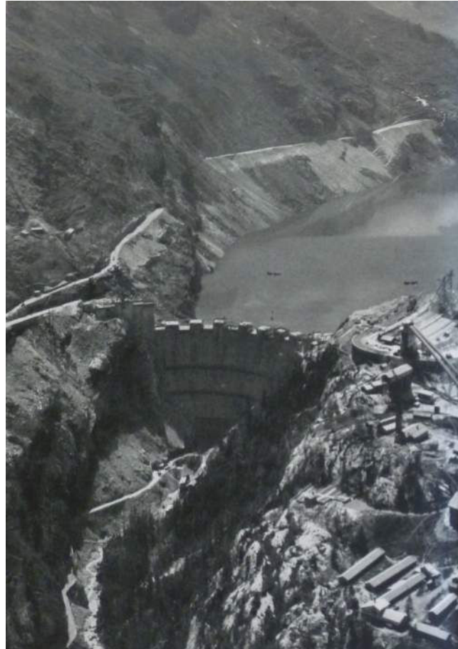
FIGURE 8. Chantier du barrage de Tignes en 1952
