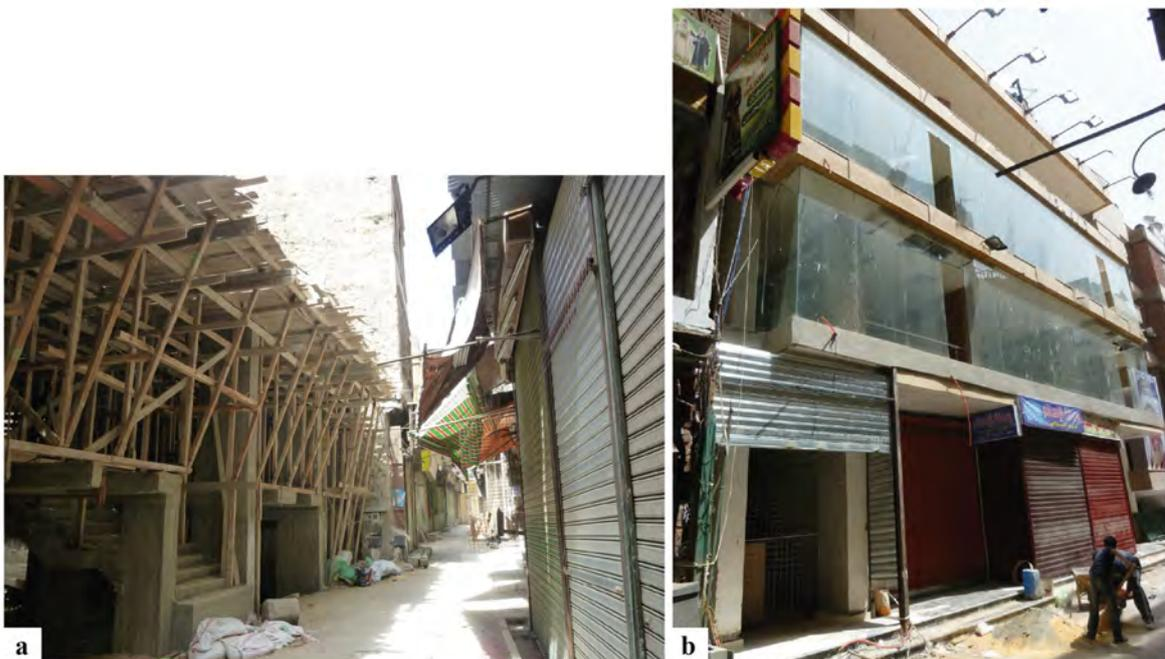
est encore en cours dans cette ruelle. Seul le rez-de-chaussée est construit, et le coffrage du premier étage est posé. Sur le cliché b, pris un an plus tard, le gros œuvre est terminé : le centre commercial compte désormais trois niveaux en plus du rez-de-chaussée, la façade est en cours de finition, les couloirs intérieurs sont carrelés et l'immeuble est prêt à être livré aux investisseurs qui vont ensuite prendre à leur charge l'aménagement et la décoration intérieure de leur boutique.
