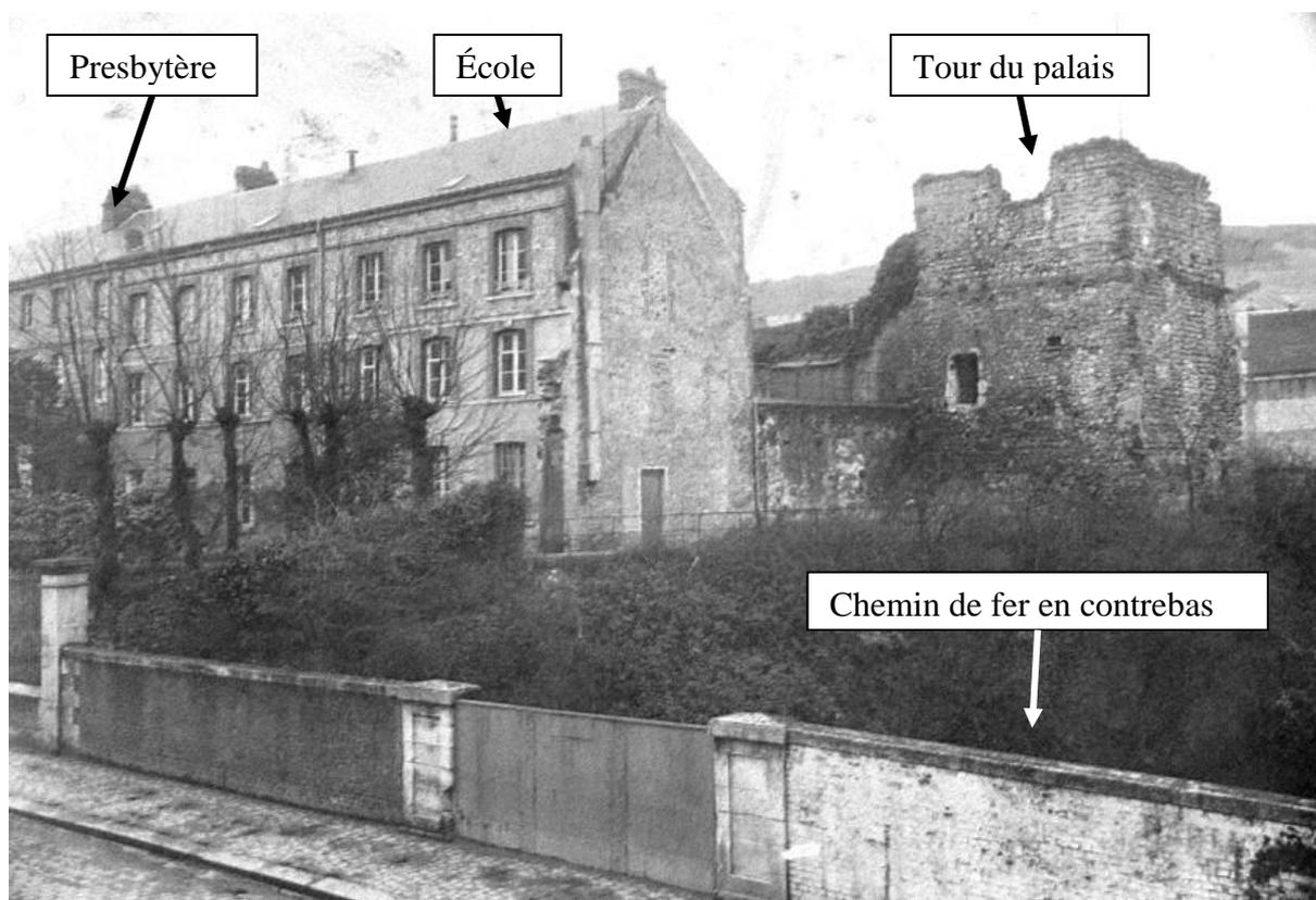
L'ancien hangar du corps de garde a été rénové. Un nouvel étage permet aux sœurs d'investir tout le bâtiment tant pour l'habitation que pour les classes. Sur le mur latéral de l'école, l'ancienne toiture a laissé des traces. Collection AMF.
