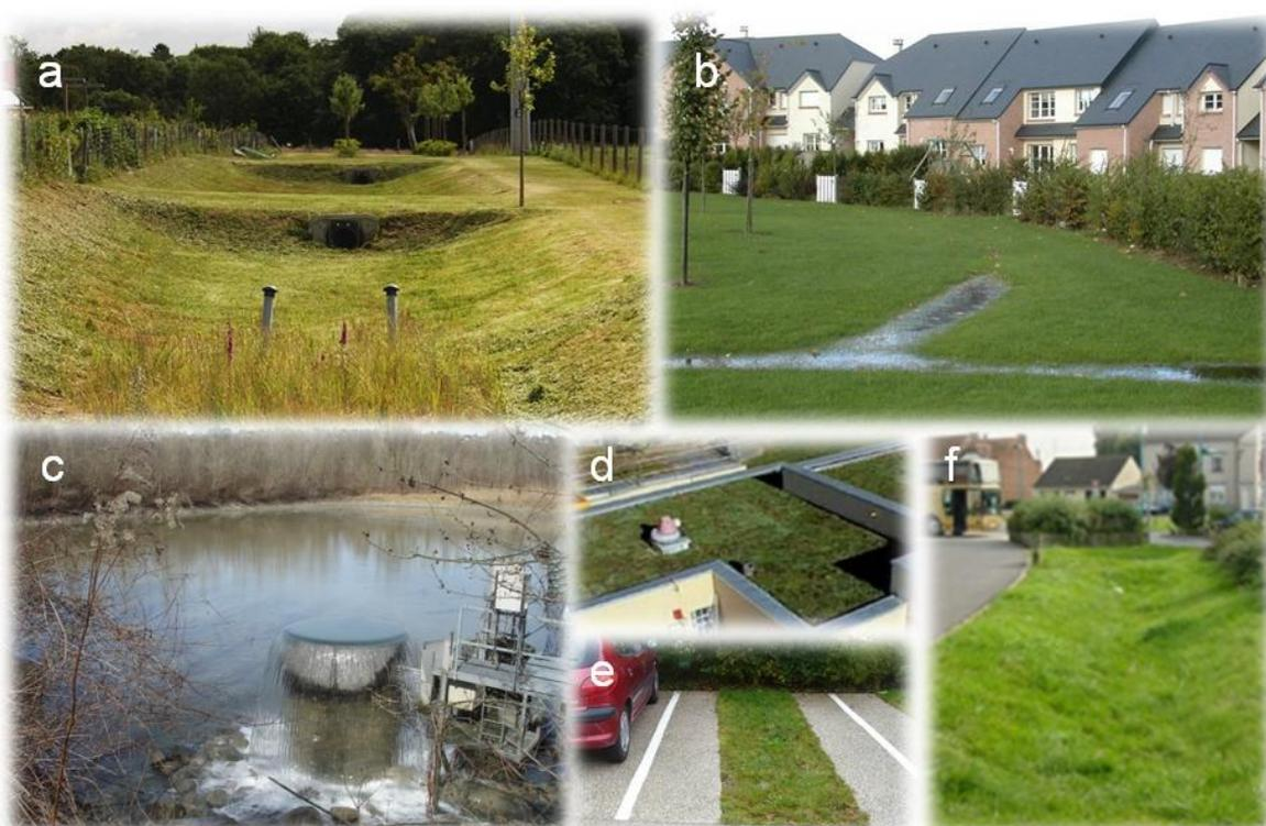
Figure 2 : Exemple de techniques alternatives, d'après CAUE27 (2014) et Grand Lyon (2008) un bassin de rétention/infiltration des eaux pluviales (a), des chemins pour les eaux pluviales intégrés dans les espaces verts (b), un bassin d'infiltration conçu pour la recharge des nappes (c), une toiture végétalisée (d), un stationnement perméable (e) et une noue (f).
