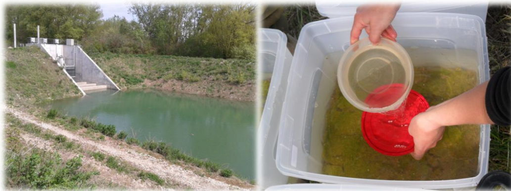
Figure 41 : Le pré-bassin (à gauche) et le remplissage des bacs (à droite)
