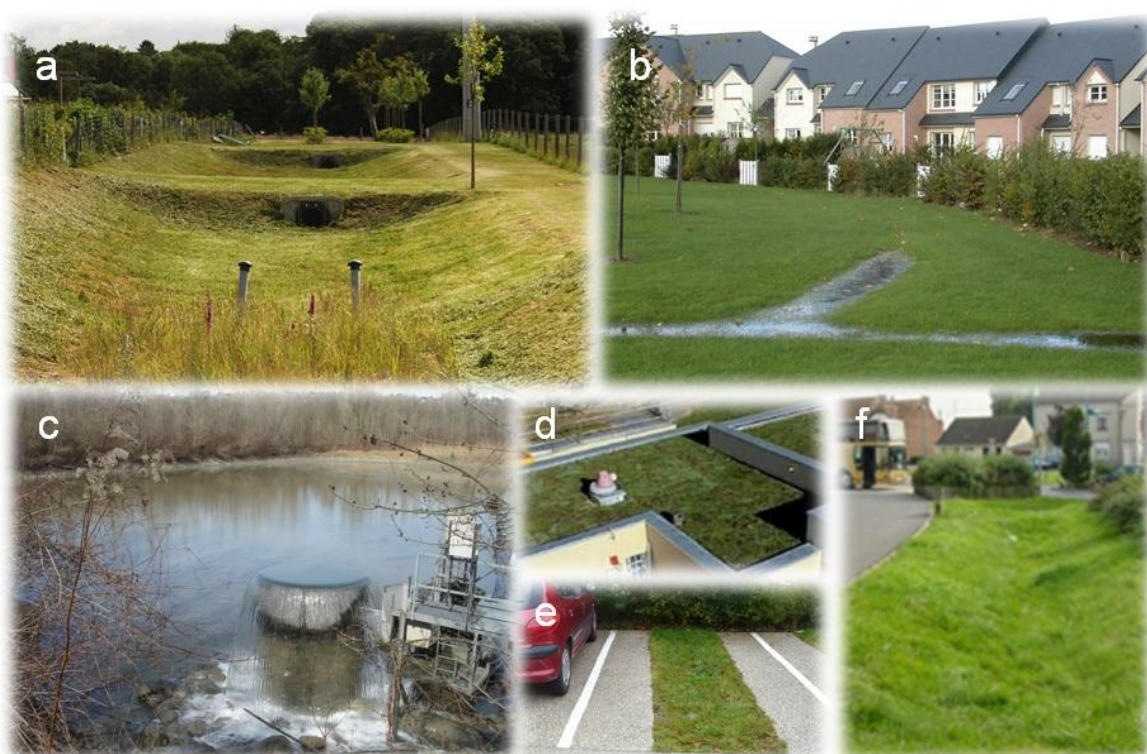
Figure 2 : Exemple de techniques alternatives, d'après CAUE27 (2014) et Grand Lyon (2008) un bassin de rétention/infiltration des eaux pluviales (a), des chemins pour les eaux pluviales intégrés dans les espaces verts (b), un bassin d'infiltration conçu pour la recharge des nappes (c), une toiture végétalisée (d), un stationnement perméable (e) et une noue (f).
