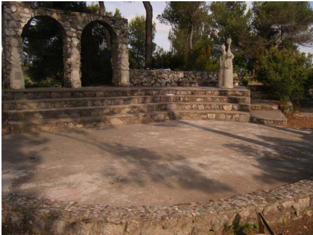
Photo. 1.13 – Vue du Théâtre : au premier plan le petit muret, puis la dalle de ciment ; au second plan les marches gradin ou scène, les arches et leurs bas-reliefs, une statue. On remarquera tout à droit de l'image le petit réduit caché derrière des buissons, pouvant servir la mise en scène.
