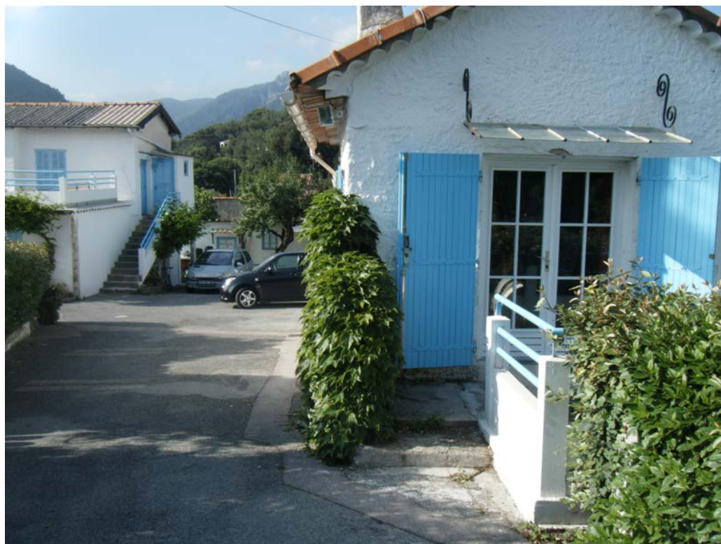
Photo. 1.31 – Le logement de fonction, à proximité du premier bâtiment de l'École, du Bungalow et de la Piscine.
