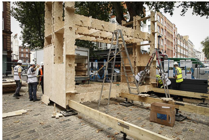
Fig. 22 Montage en cours
