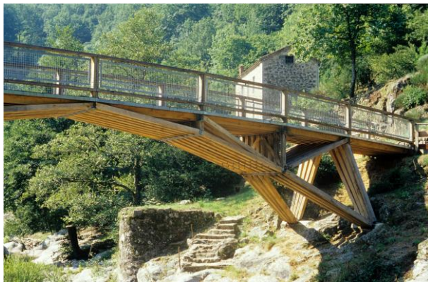
Fig. 3 Appuis sur berges
