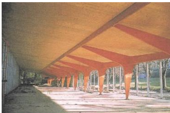
Fig. 18, Buvette d'Evian, vue intérieure, sous face des panneaux Rousseau
