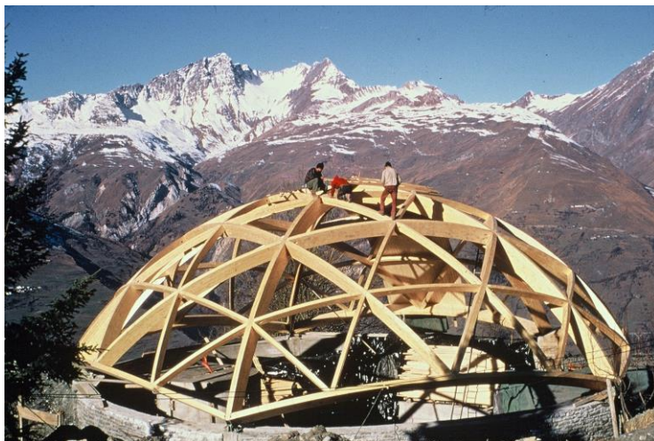
Fig. 6 Dôme géodésique de l'auditorium de Bourg-Saint-Maurice
