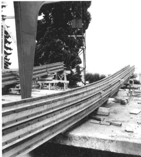
Fig 20 Poutres courbes de la toiture
