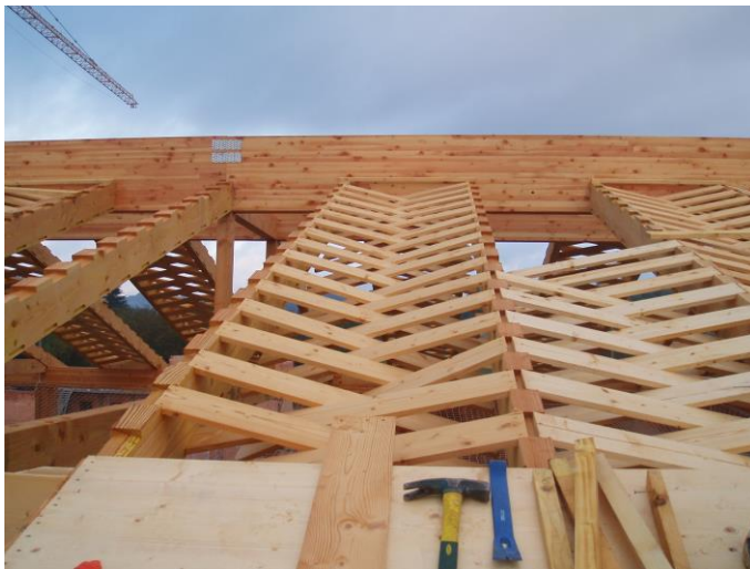
Fig. 13 Pose des étrésillons croisés
