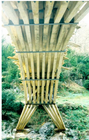
Fig. 4 Sous-face de la passerelle
