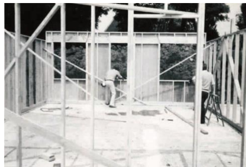
Fig.17 Chantier ossature bois
