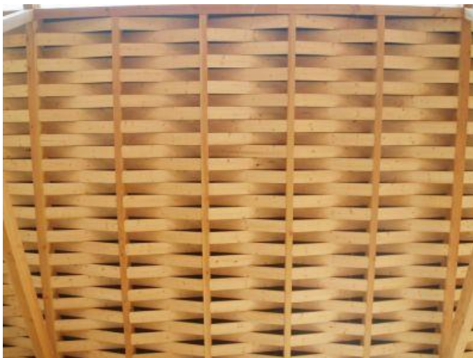
Fig. 14 Sous-face « tressée » acoustique
